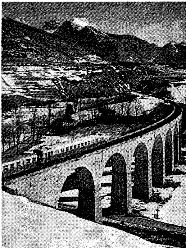
Slika 4. Kameni železnički most
