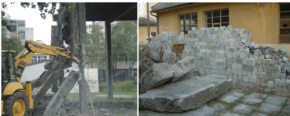
Slika 17. Rušenje konstrukcije (levo) i betoni koji su reciklirani u agregate "A" i „B“
