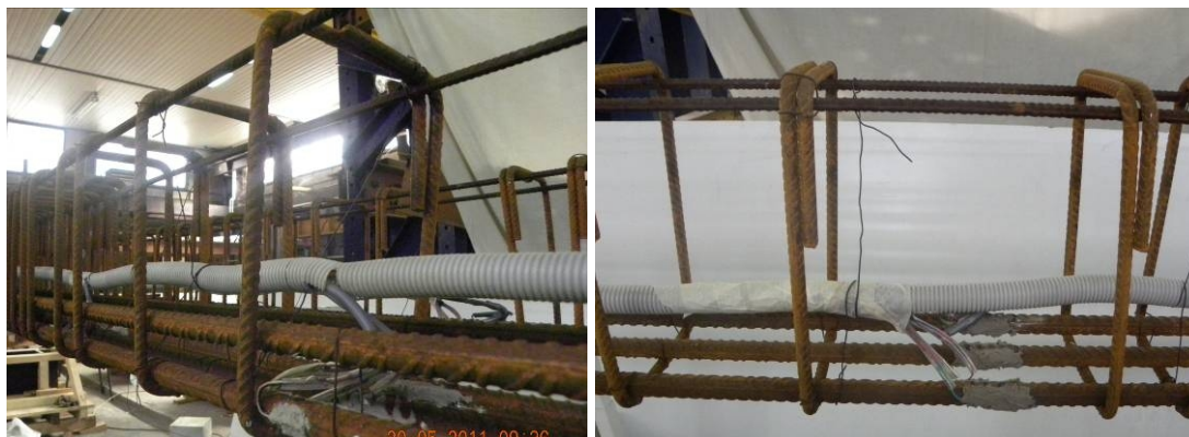
Slika 38. Vođenje kablova sa mernih traka duž grede
