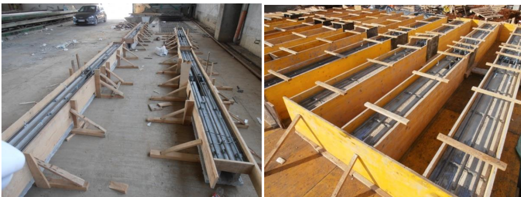
Slika 4-5 Pripremljene grede neposredno pre betoniranja
