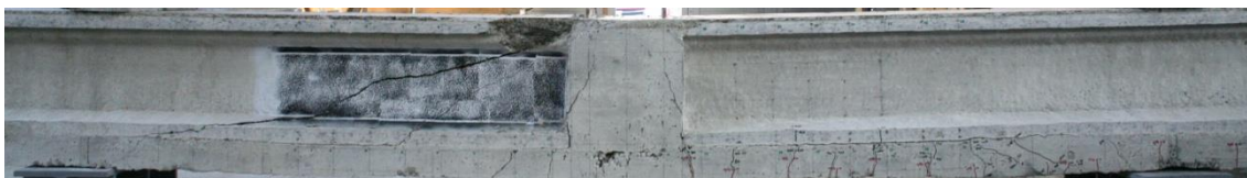
Slika P .2-9: 350-135/135-2: Prikaz prslina nakon loma grede: na južnom (a) i severnom licu grede (b)
