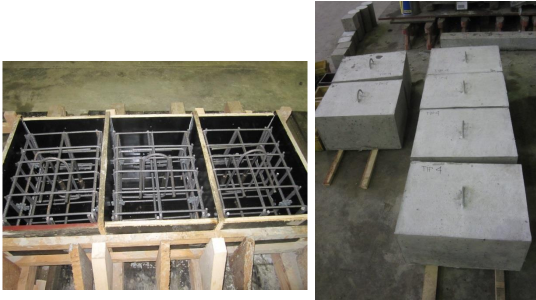
Slika 3.9 Oplata sa armaturom i izbetonirani elementi serije D
