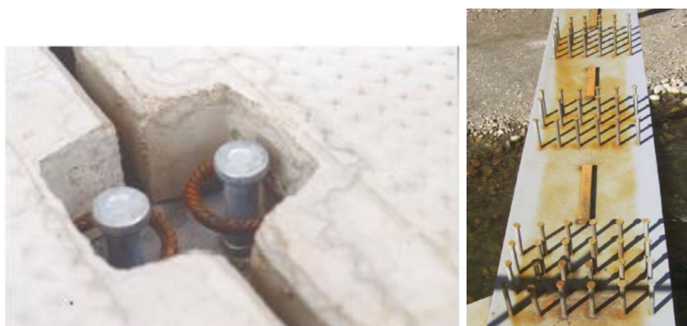
Slika 1.2 Montažne AB ploče spregnute grupom moždanika [Koster, 2005]
