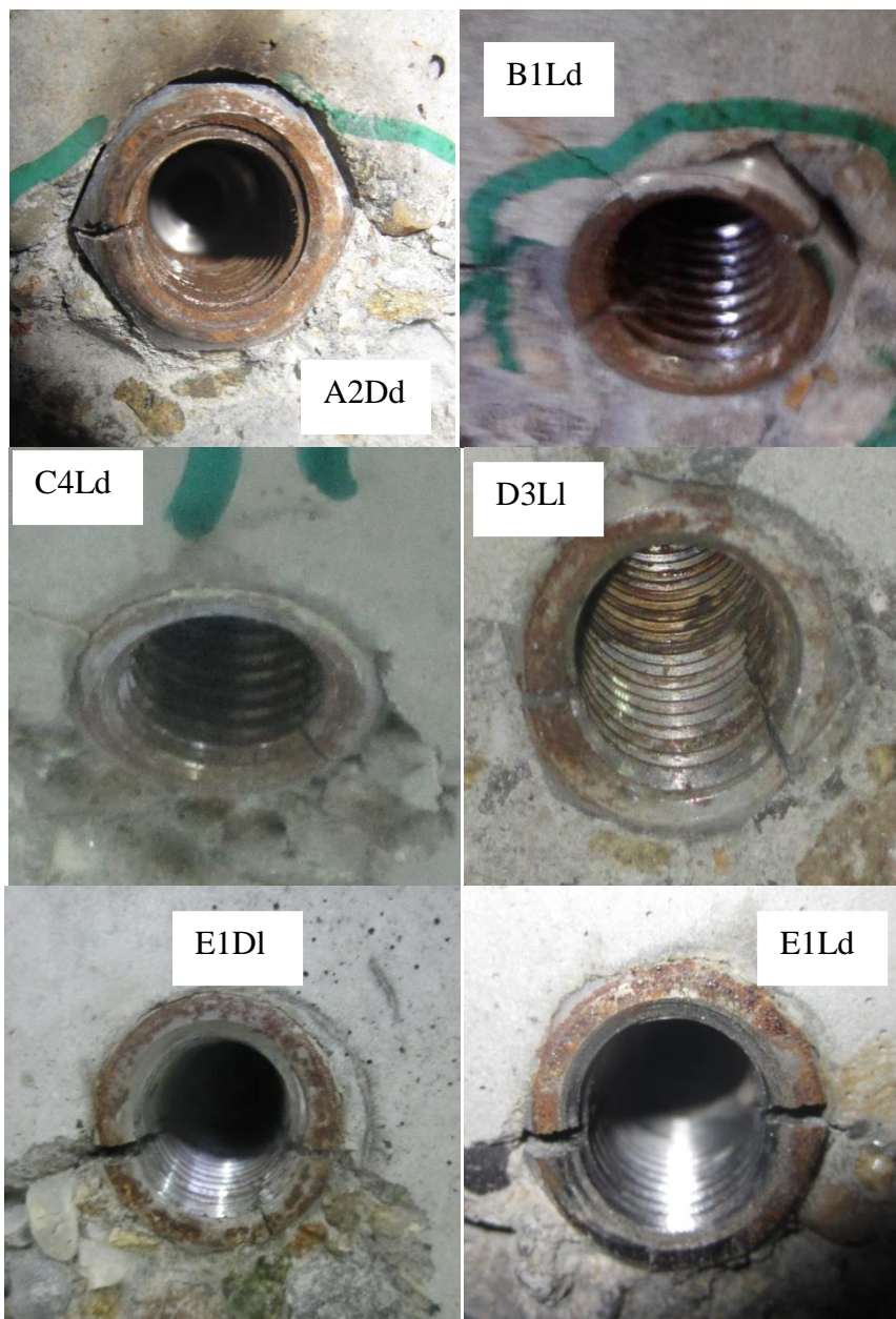
Slika 3.48 Oštećenja mehaničkih spojnica na ispitivanim uzorcima
