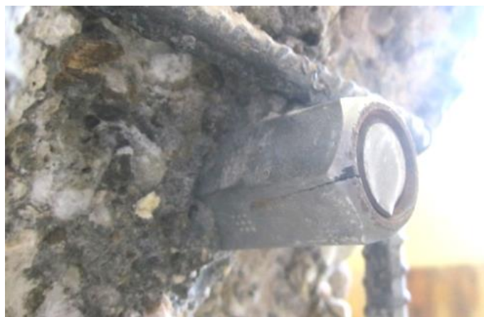
Slika 3.50 Primer oštećene mehaničke spojnice posle loma zavrtnja na smicanje (Uzorak A2)
