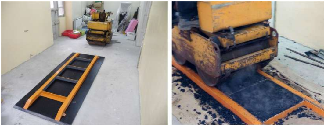
Slika 3.17 Procedura ugradnje asfaltne mešavine u poligon
