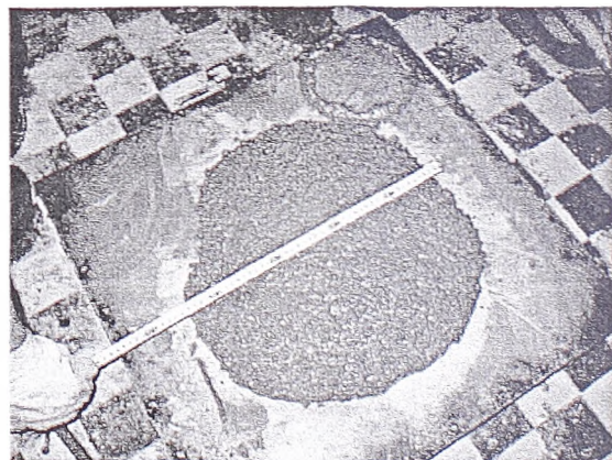
Слика 7.7 Распрострањање бетона прве партије
