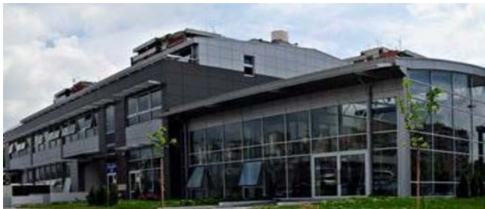
Slika 1 - Izgled postojećeg stanja poslovnog objekta "Autocentar Stojanović"
