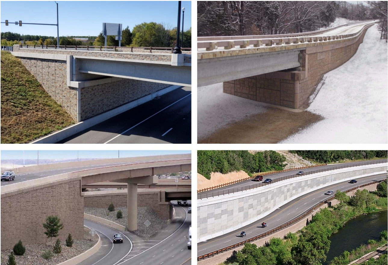
Slika 13. Primeri estetski uspešnog uklapanja MSE zidova na putnim objektima u postojeće prirodne oblike i ambijentalnu sredinu (Izvor: L.9 i L.12)
