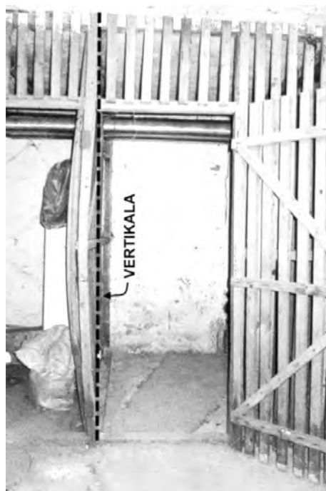
Slika 10. Izvijanje drvenih letvica u podrumskim ostavama
