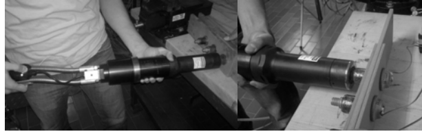
a) b) Slika 7. Ugradnja HBT zavrtnjeva prečnika 20 mm: a) crvena lampica kao indikator rada opreme za ugradnju b) postavljanje opreme u položaj za rad
