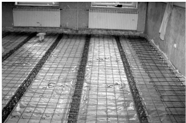
Slika 10. Izgled jedne od učionica neposredno pre betoniranja
