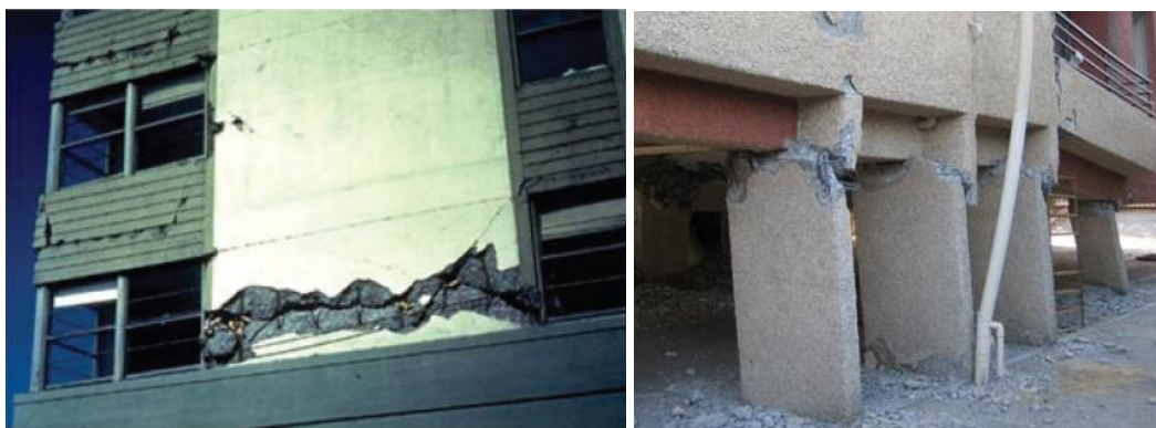
Slika: 5.12 (levo) Lom AB zida smicanjem, nedostatak grupisanja armature na krajevima zida, Aljaska 1964, (desno) lom smicanjem Maipú., Čile 2010, (slika: Dr. Tao Lai)
