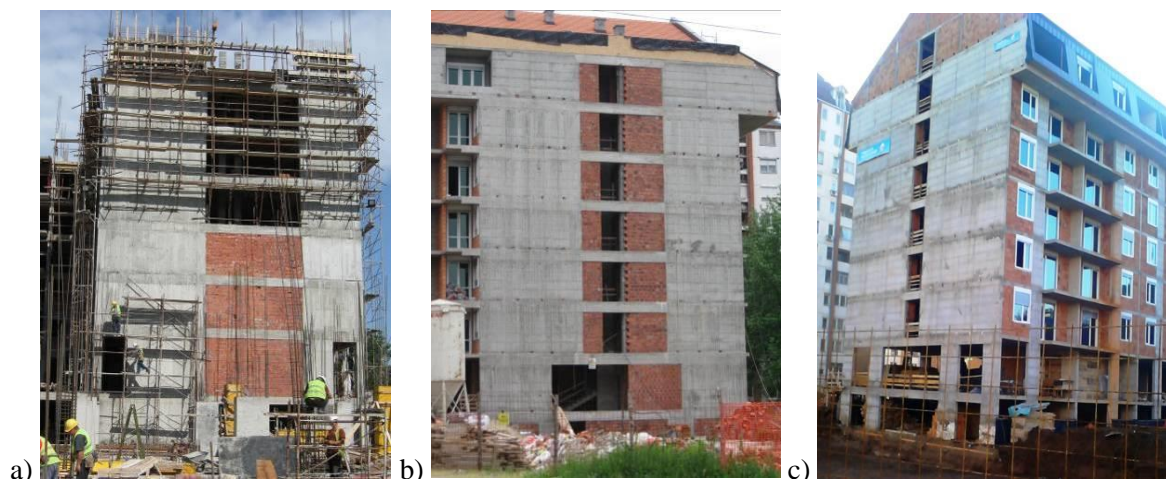
Slika: 6.13 Primeri neregularnih AB zidova – „fleksibilno prizemlje“, (slika: P. Petronijević)
