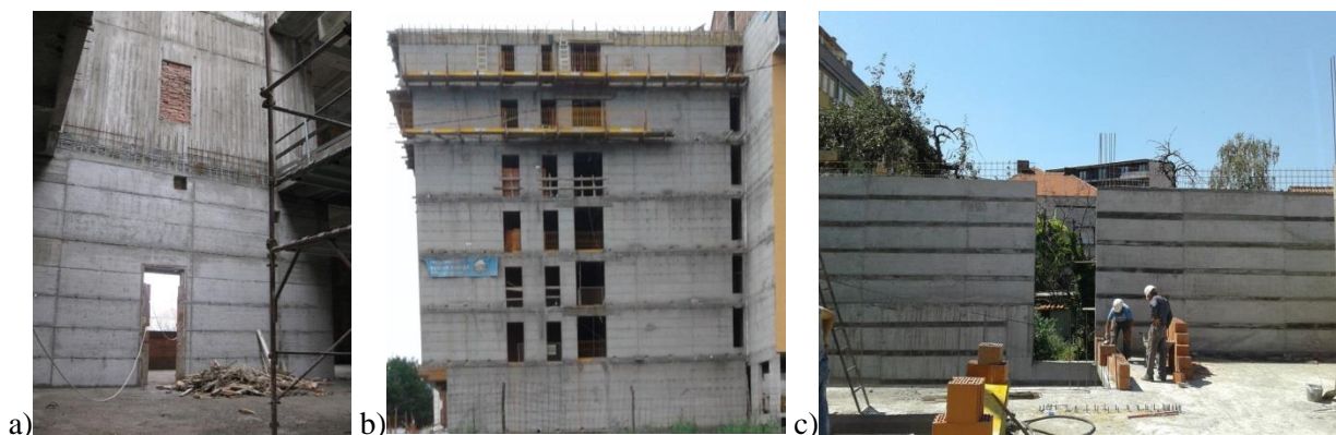
Slika: 8.70 a) kruto povezani zidovi bez mogućnosti formiranja grednog mehanizma, b) povezani asimetrični zidovi velike krutosti (bez efekta povezivanja), c) simetrični zidovi velike krutosti i male spratnosti (bez efekta povezivanja), (fotografija: P. Petronijević)
