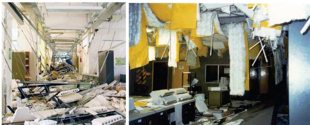
Slika: 2.6 Oštećenja nekonstruktivnih elemenata: spušenih plafona, osvetljenja, ventilacionog sistema u industrijskom postrojenju, Peru, 2001 godine, magnituda 8.4, (slika: BFP Engineers)
