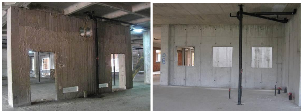
Slika: 6.11 Konceptualno loš raspored otvora u AB zidovima (slaba etaža), (slika: P. Petronijević)
