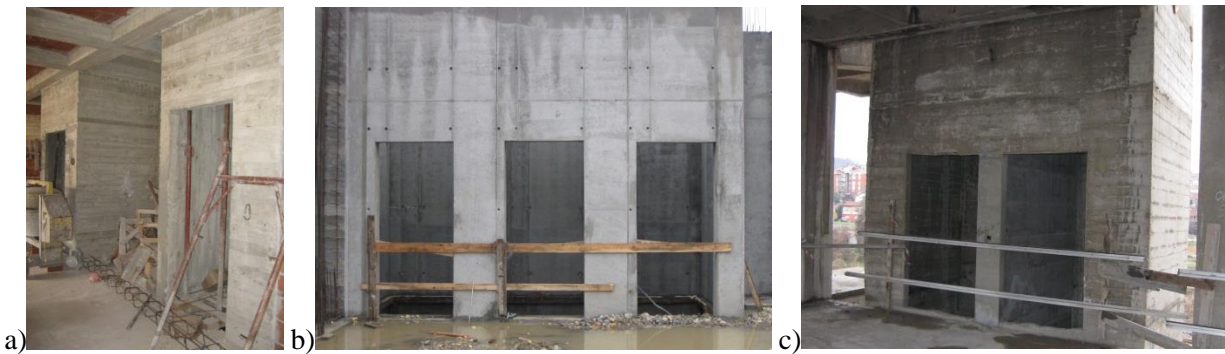
Slika: 8.23 Mesta potencijalnog povezivanja zidova bez pozitivnih efekata, (fotografija: P.Petronijević)
