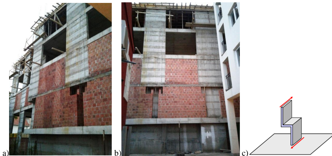
Slika: 6.14 Primeri neregularnih AB zidova – „offset zida van jedne ravni“, (slika: P. Petronijević)
