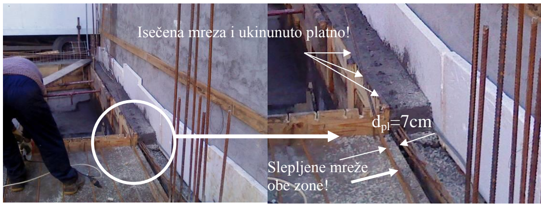
Slika: 6.49 Primeri smanjenja AB platna na 7cm u podrumu i potpuno ukidanje AB zida iznad zemlje
