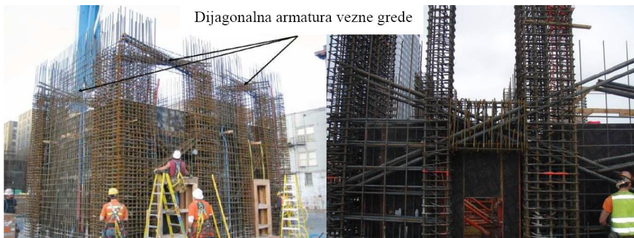
Slika: 3.6 Dijagonalno armirane vezne grede, slika: (Wallace i sar, 2007)
