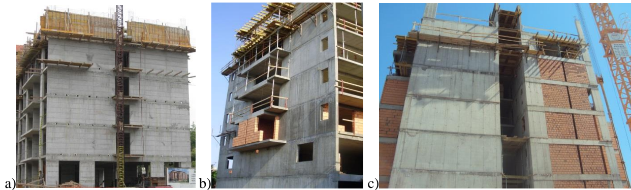
Slika: 8.21 Potencijalna mesta povezivanja zidova koja nisu iskorišćena već pretvorena u neregularnost zgrada, (fotografija: P. Petronijević)
