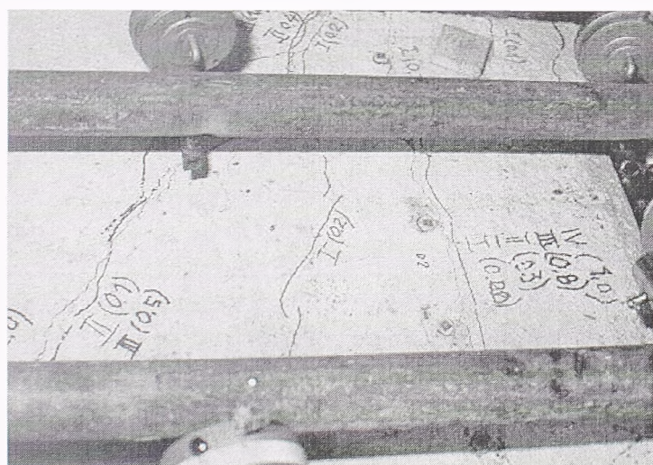
Slika 4.4 Detalj prslina od savijanja u okolini otvora za stub
