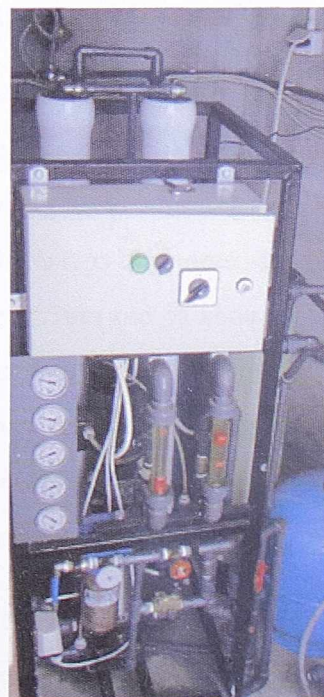
Slika 7-1. Javna česma u MZ Obrovac: a) objekat česme pored bunara B3, b) prečistač vode
