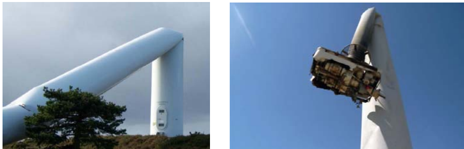
Слика 5 – Губитак стабилности стуба ветрогенератора Figure 5 – Wind tower loss of stability
