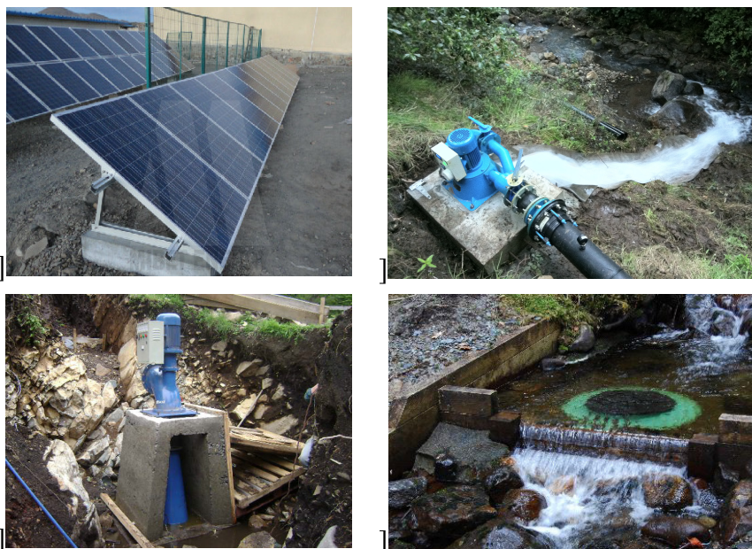
Slika 2 –Konstruktivni i nekonstruktivni elementi od betona u sklopu sistema za proizvodnju električne energije iz obnovljivih izvora
