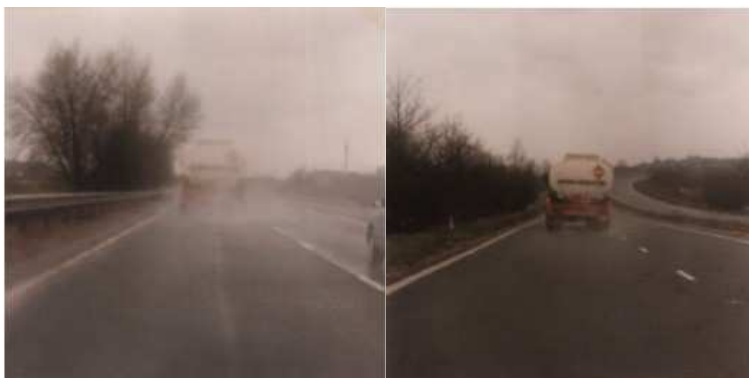
Slika 3. Kamion na putnoj sekciji zbijenog (levo) i poroznog (desno) asfalt-betona [1]
