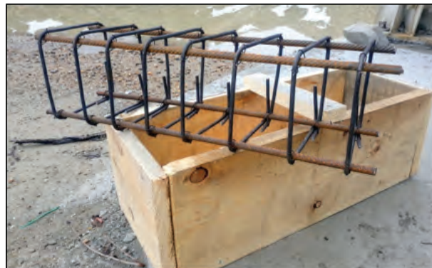
Slika 2. Prikaz oplata i armaturnog koša za betoniranje elemenata [2]
