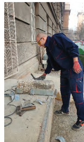
Slika 6. Uklanjanje karbonskih tkanina sa elemenata
