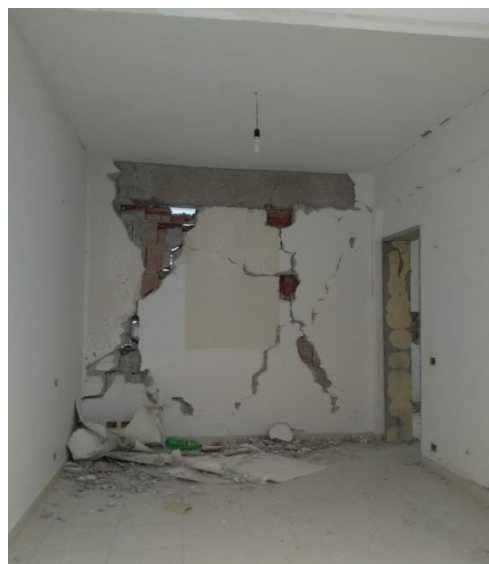
Slika 4-15: Dijagonalne pukotine u zidanoj ispuni
