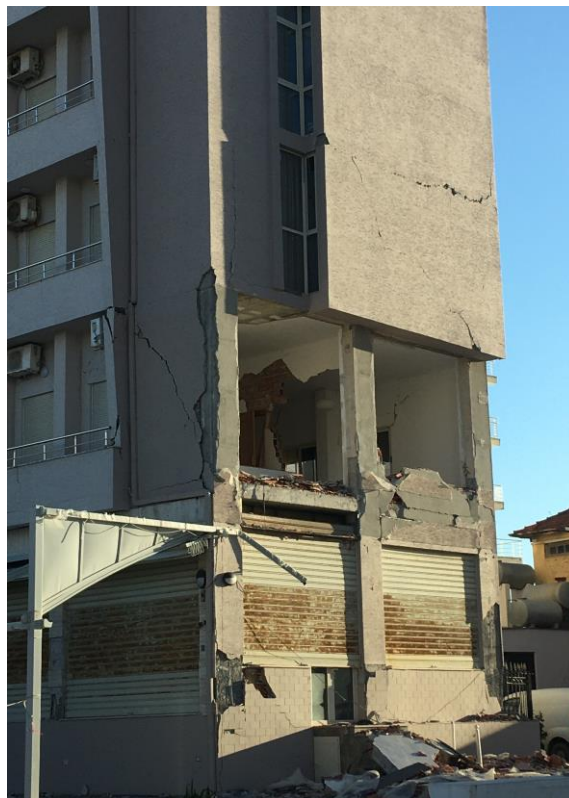
Slika 4-17: Lom i ispadanje zida van ravni na zgradama u Draču (Durrës)
