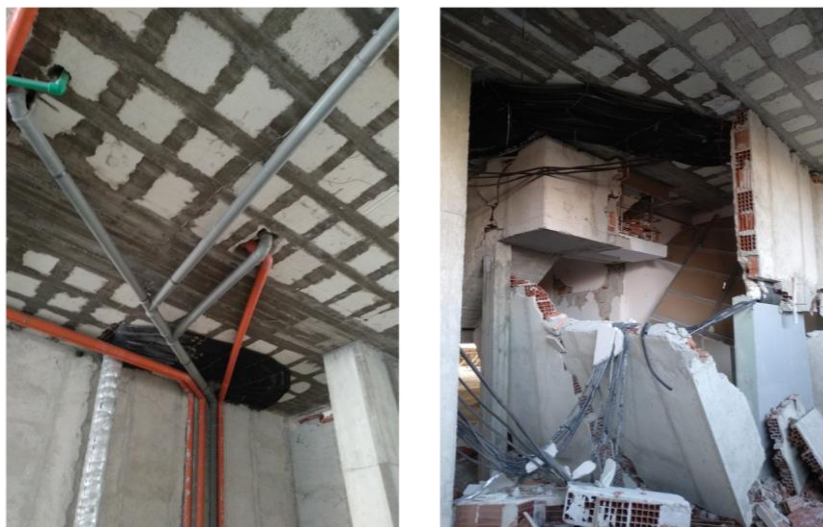
Slika 7-8: Primeri instalacija: a) daleko od ispuke i b) blizu ispuke, „fleksibilna zgrada“ u Draču ( Durrës )
