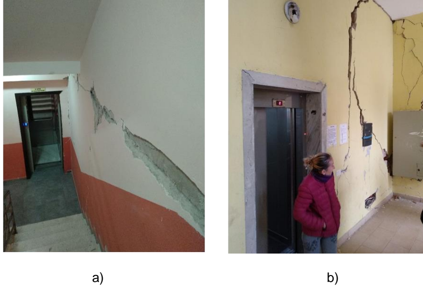
Slika 7-5: Primeri funkcionalnih liftova u oštećenim objektima: a) zgrada u Draču (Durrës) i b) zgrada u Fuše-Kruja (Fushë-Krujë)
