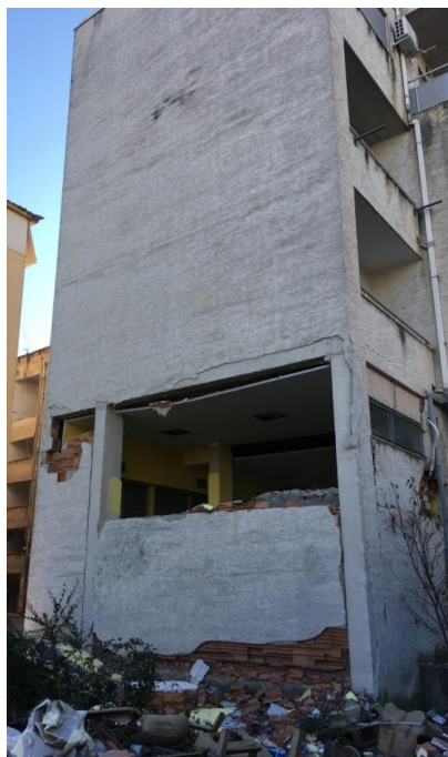
Slika 4-14: Oštećenja zidane ispune na periferiji objekata u Draču (Durrës)
