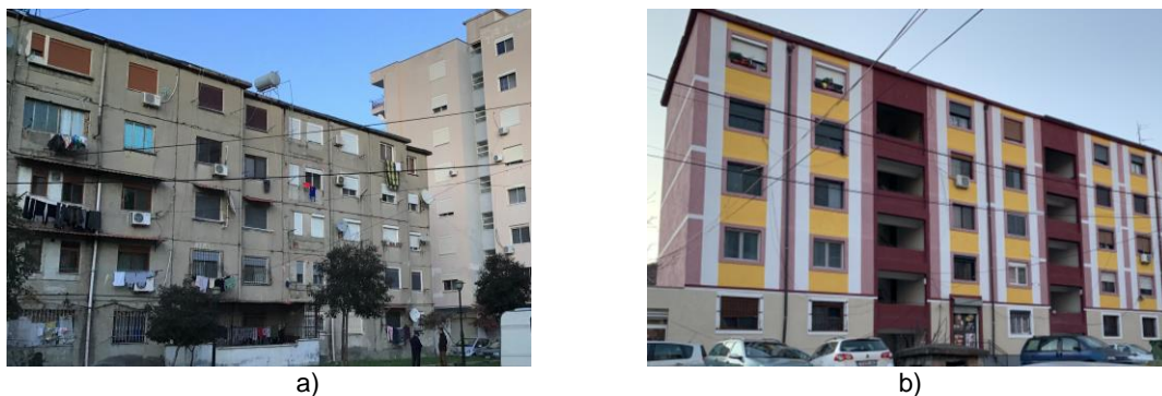
Slika 3-9: Prefabrikovane AB zgrade srednje visine: a) tipična zgrada sa krupnopanelnim sistemom gradnje (levo) i susedna 8-spratna moderna zgrada sa AB ramovskom konstrukcijom (desno), Drač i b) renovirana zgrada sa krupnopanelnim sistemom gradnje, Vore
