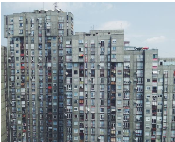
Slika 4-25: Krupnopanelne AB zgrade u sistemu “Rad-Balancy”, Blok 63, Novi Beograd
