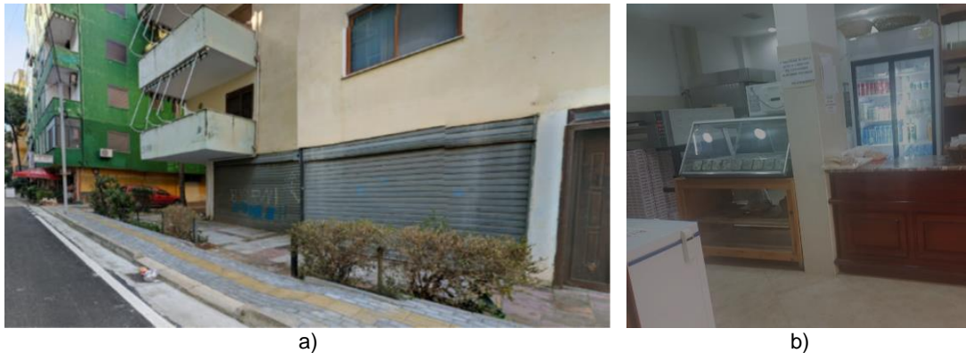
Slika 3-8: Zgrade sa hibridnim konstrukcijskim sistemom: a) fasada zgrade koja pokazuje otvoreno prizemlje (metalna vrata umesto zidova), i b) unutrašnjost zgrade na nivou prizemlja - vidi se AB stub (fotografije: Google)
