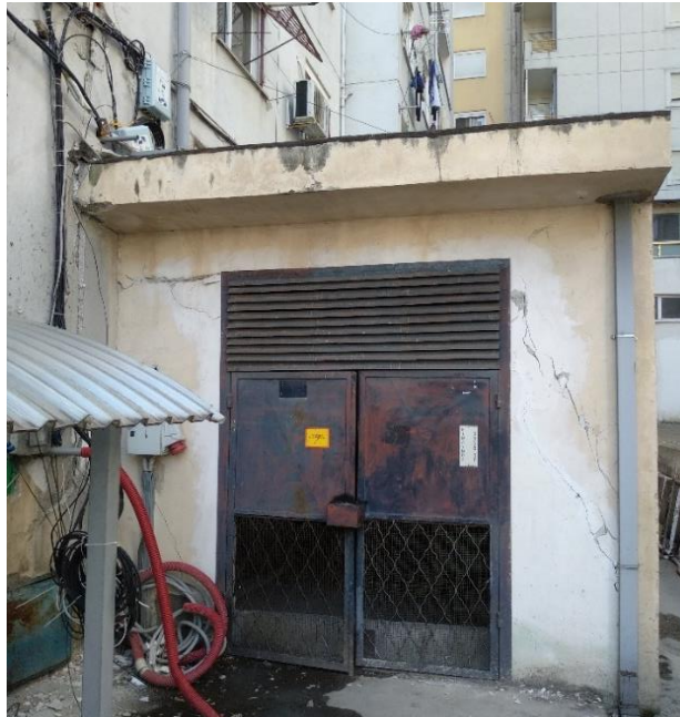
Slika 6-2: Prsline na podstanici distributivnog sistema u Draču ( Durrës )
