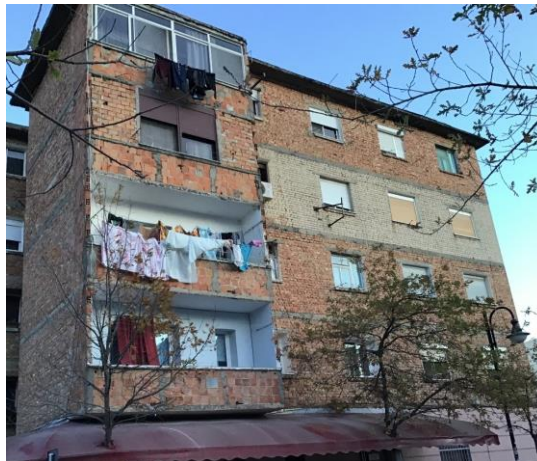
Slika 5-4: Korišćenje različitih zidanih elemenata u istoj zgradi
