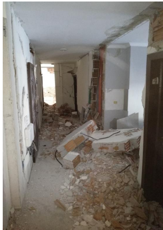
Slika 4-22: Oštećenje i ispadanje ispune van ravni unutar zgrade u Draču (Durrës)
