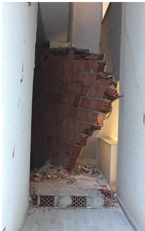
Slika 4-17: Lom i ispadanje zida van ravni na zgradama u Draču (Durrës)
