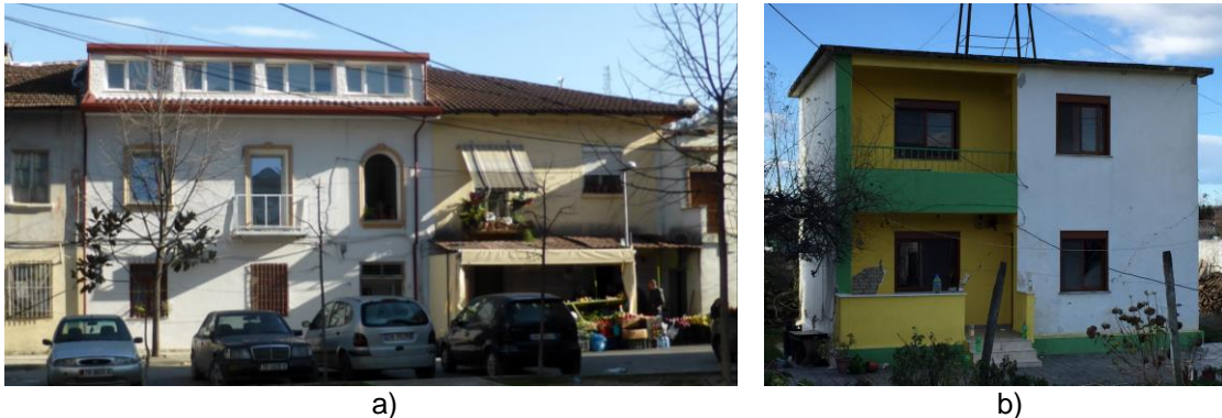
Slika 3-6: Niske zidane zgrade: a) urbane zgrade u nizu (Tirana) i b) seoska zgrada od nearmirane zidarije (Tumane)
