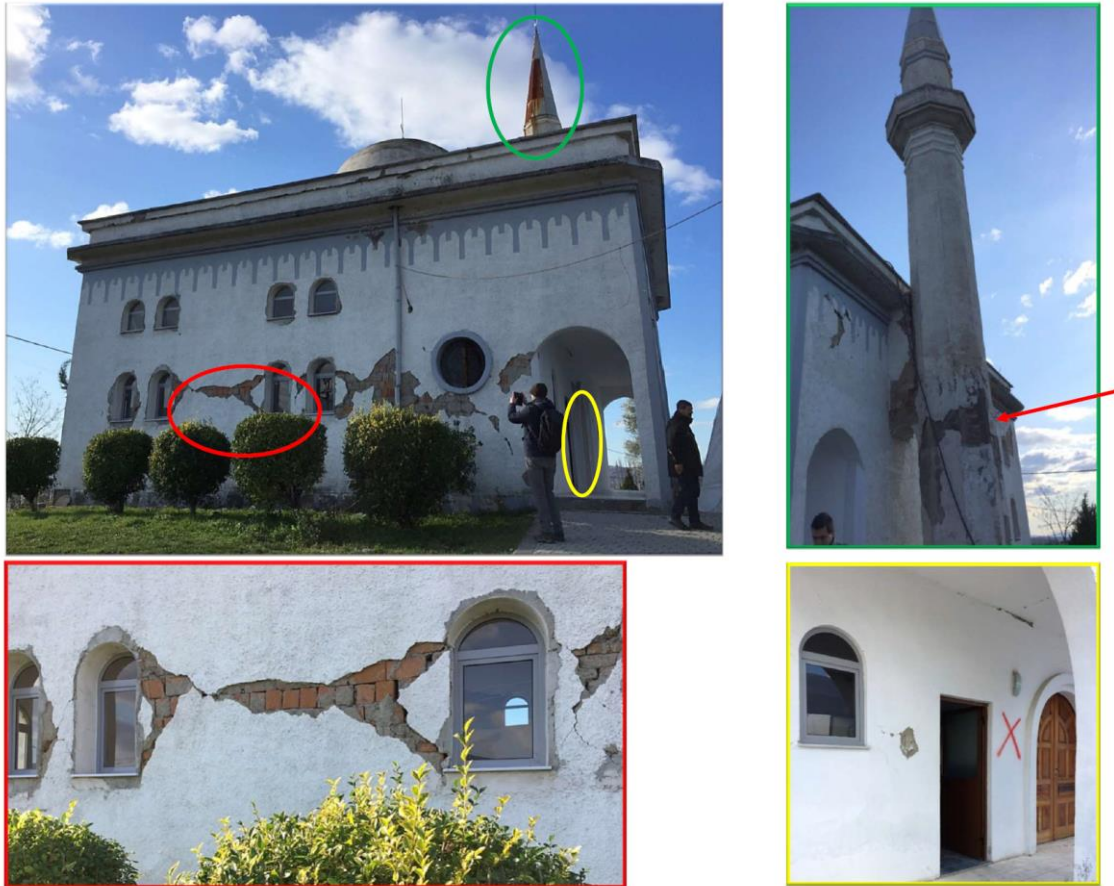
Slika 5-17: Spoljašnjost džamije u mestu Tumanë (Thumanë): oštećenja istočnog zida i minareta na zapadnoj strani džamije
