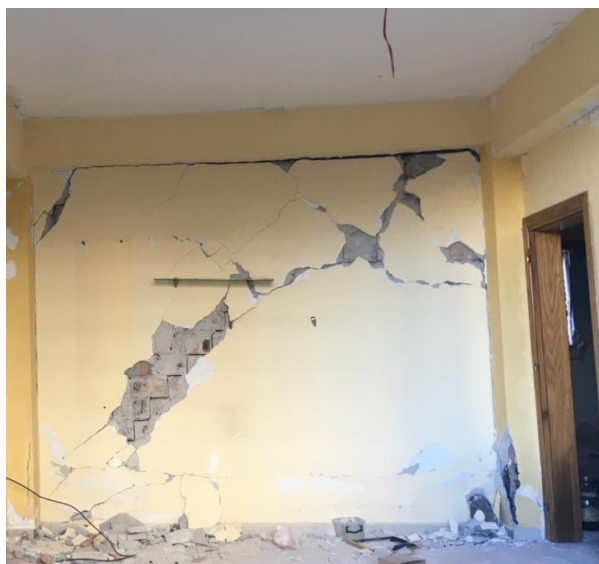
Slika 4-15: Dijagonalne pukotine u zidanoj ispuni
