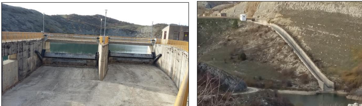
Слика 4. Преливни праг са уставама и брзоток прелива бране Врба
