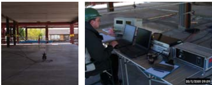
Динамичко испитивање међуспратне конструкције
