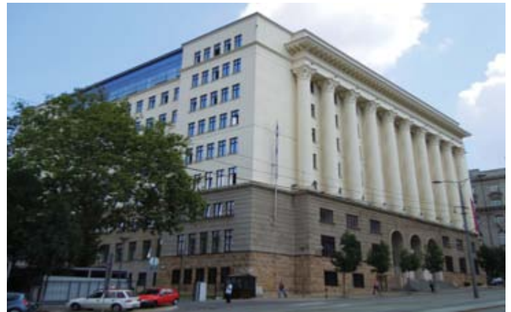
Реконструисан објекат у ул. Немањина бр. 9 у Београду
