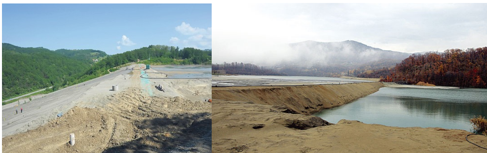
Slika 2. Levo: Nasuta brana jalovišta. Desno: Pogled na jalovište. Figure 2. Left: Side view of the embankment dam. Right: A view to tailing reservoir.
