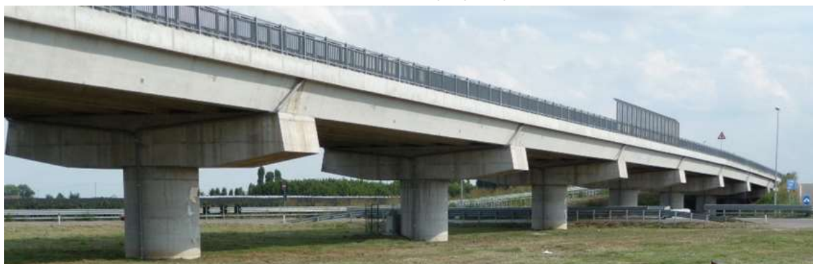
Slika 1 – Isola Della Scala Bridge – najduži betonski integralni most na svetu ( L=400.8 m) [5]
