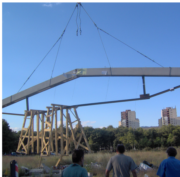
Slika 10.24 – Sklanjanje nosača
