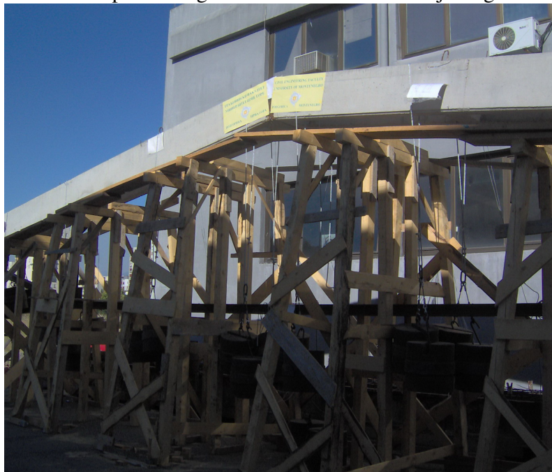
Slika 5.6.5.3. Izgled nosača u toku ispitivanja pri III fazi opterećenja
