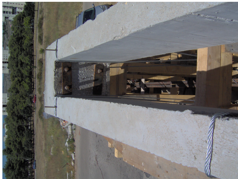
Slika 5.4.5. Izgled veze nosača u slemenu
