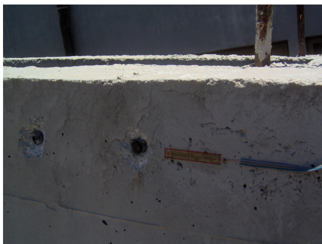
Slika 10.14 – Merno mesto na armaturi
