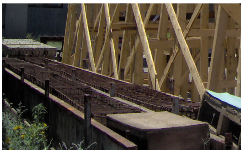
Slika 5.4.2. Oplata i armatura za jedan model-nosač
