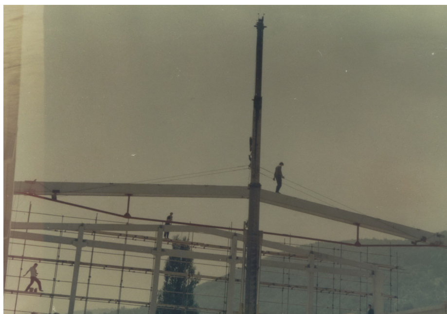
Slika 4.2. Dvopojasni nosači sa donjim pojasom u vidu zatege za halu u Sevojnu
