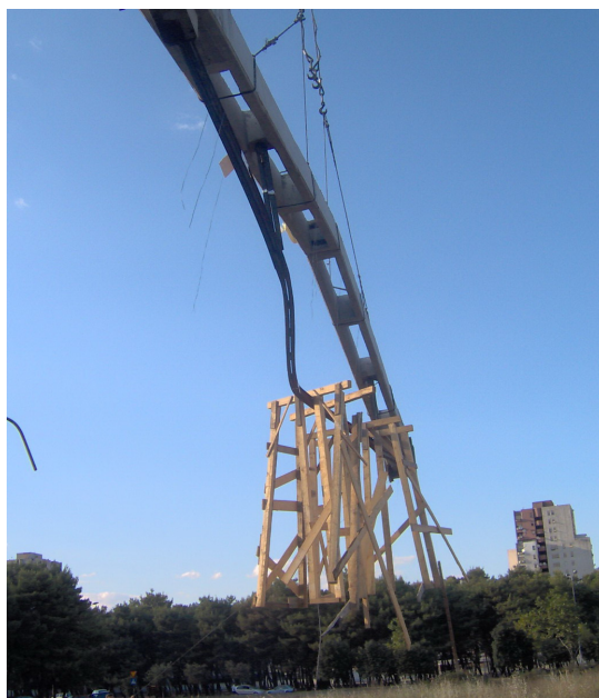
Slika 4.21. Pogrešno “hvatanje” nosača dovodi do izvijanja zatege
