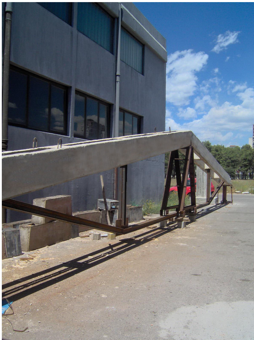
Slika 5.4.6. Izgled kompletnog nosača na privremenim osloncima nakon montaže elemenata nosača
