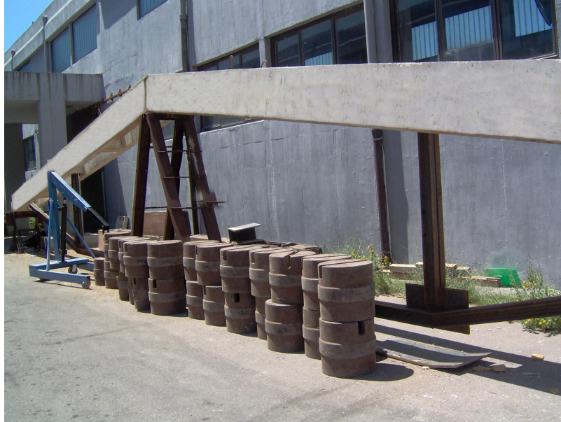
Slika 5.4.4. Izgled formiranog nosača na privremenim osloncima
