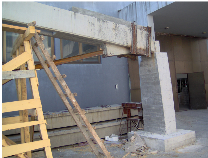
Slika 5.5.1. Sanirani nosač u oslonačkom delu
