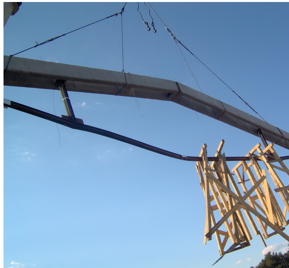
Slika 10.23 – Sklanjanje nosača
