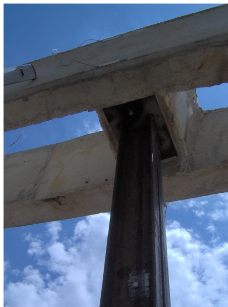
Slika 10.18 – Izgled veze vertikalne i gornjeg pojasa
