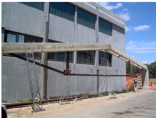
Slika 10.4 – Izgled nosača na betonskim osloncima
