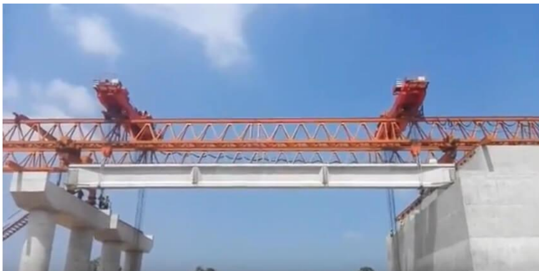
Slika 4.9 Primena montažne lansirne rešetke kod monaže AB prednapregnutog nosača [1]
