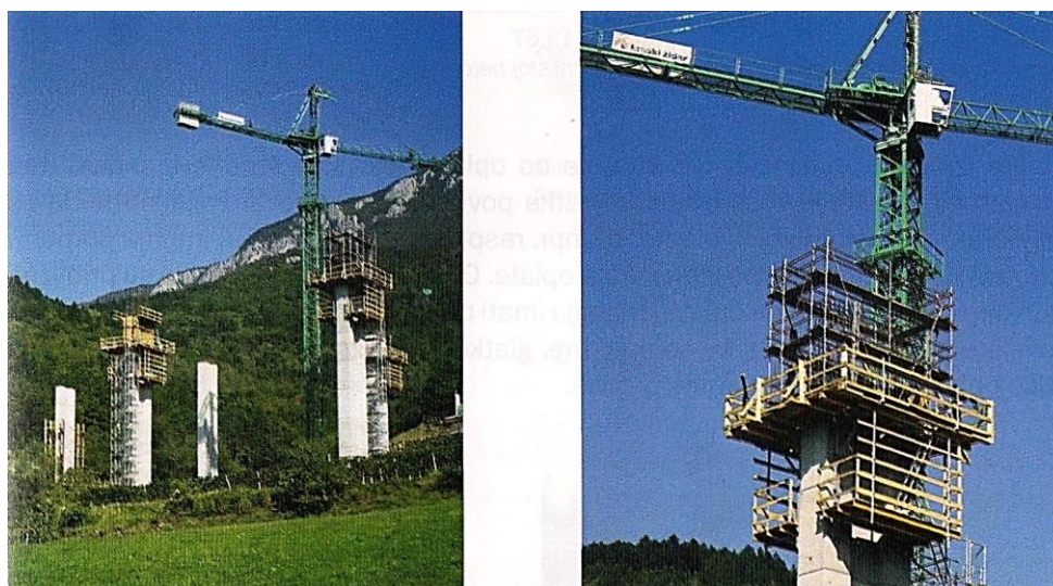
Slika 4.10 Betoniranje stubova konstantnog preseka sa prenosnom skelom u segmentima 3,0 m
