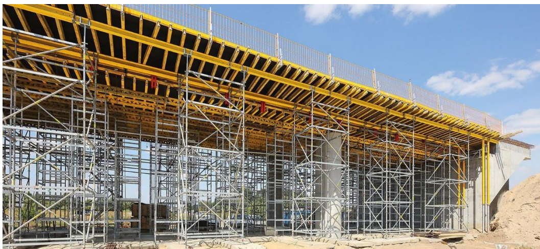
Slika 4.4 Cevna fiksna skela kod betoniranja nadvožnjaka [70]
