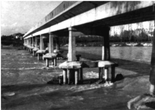
Slika 12.13: Primer erozijom korita ogoljenih šipova na kojima su fundirani mostovski stubovi (reka Brenta u Italiji) [3].
