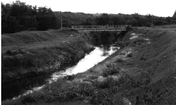
Slika 6.17: Primer mostovskog otvora nedovoljne propusne moći za evakuaciju velikih voda (reka Lepenica kod mesta Gradac).
