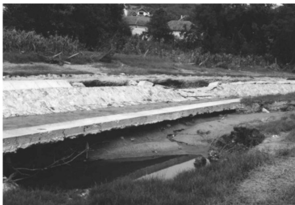
Slika 12.8: Erozijom potkopana obaloutvrda regulisanog korita nakon prolaska poplavnog talasa (Dulenska reka, pritoka Velike Morave, 1999).
