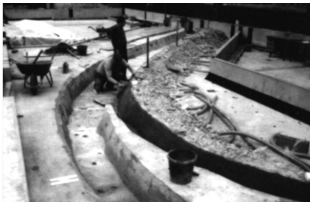
Slika 13.1: Izgradnja modela deonice reke Sene nizvodno od Pariza u cilju ispitivanja plovidbenih uslova u zoni račvanja toka [46].
