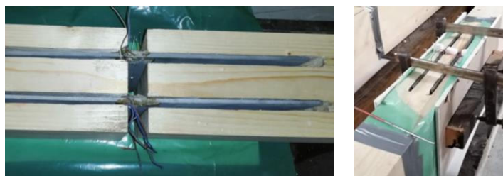
Slika 3. Ugradnja čeličnih ploča u proreze
