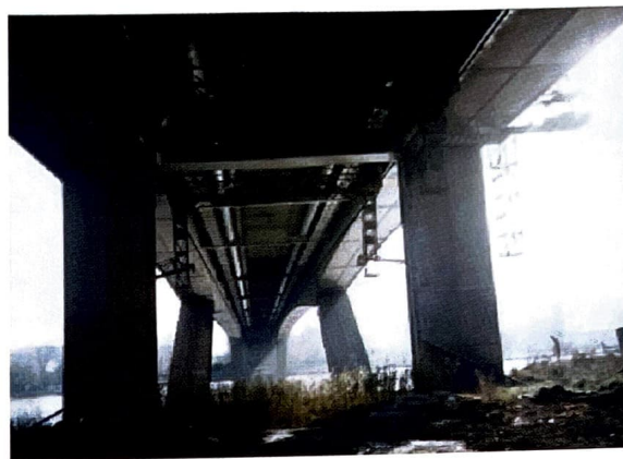
Slika 6. Cevovod na mostu Gazela
