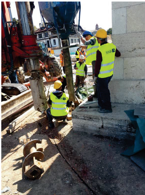
Slika 4 - Priprema za ugrađivanje betona u šip
