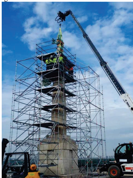
Slika 7 - Montiranje „Pobednika“ nakon restauracije i ojačanja temelja stuba i oslonca figure
