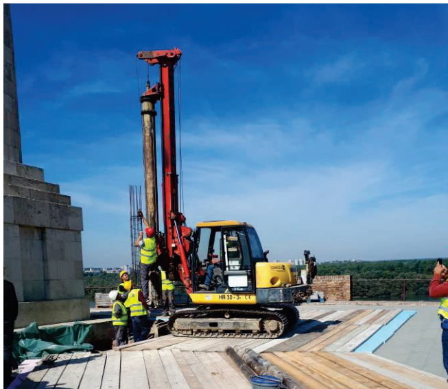
Slika 2 - Ugradnja armaturnog koša za šip
