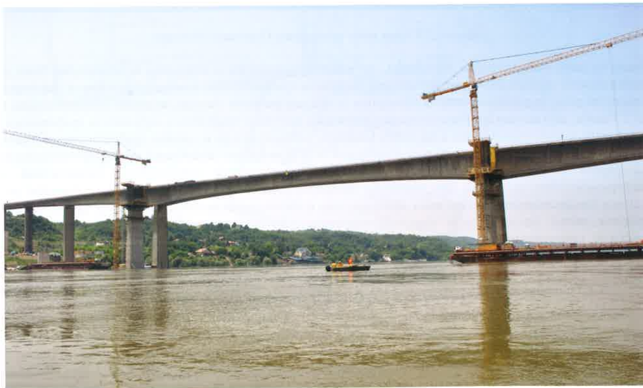
Слика 3. Мост преко Дунава код Бешке током изградње "моста близанца"
