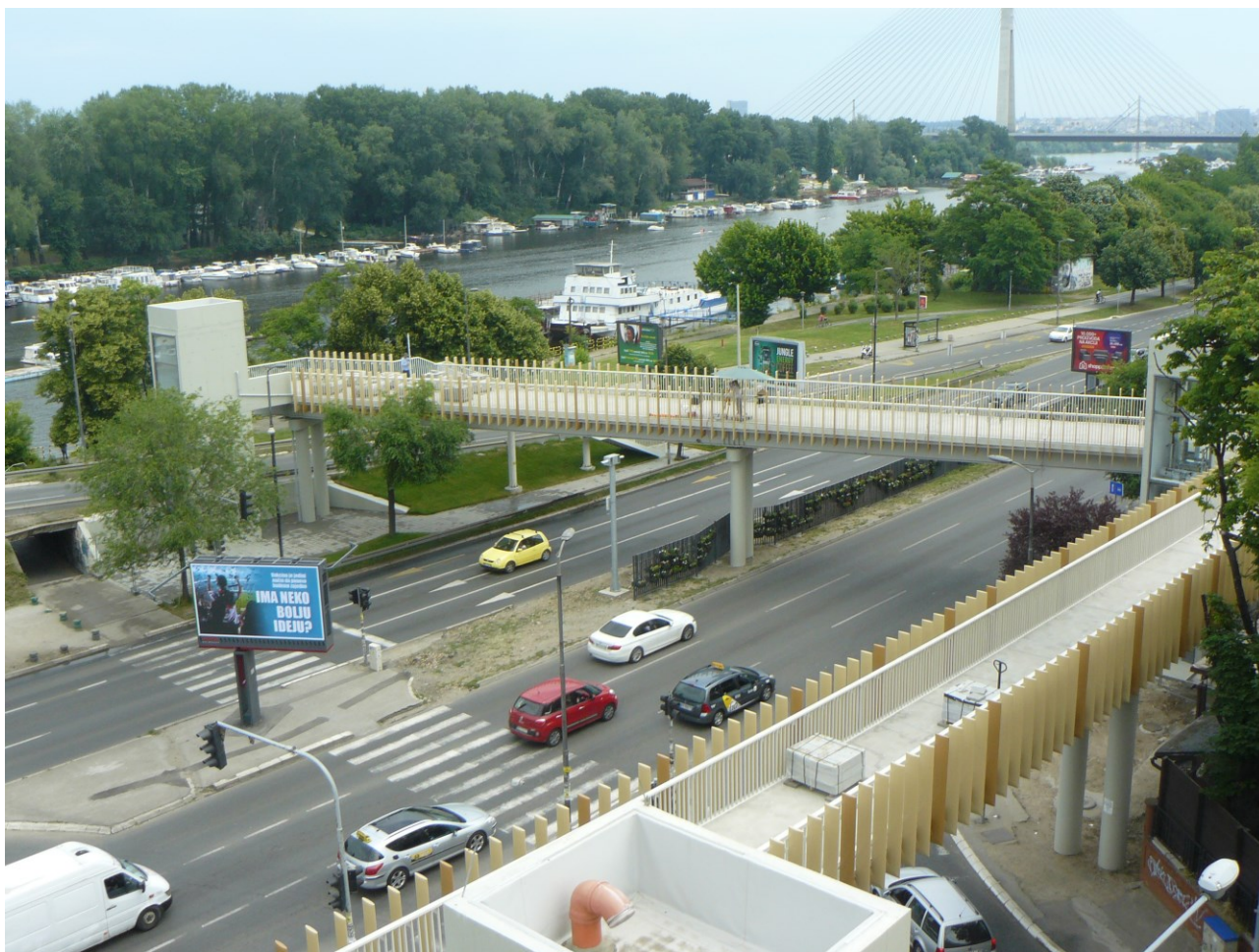
Слика 3. Фотографија испитивања пешачко-бициклическог моста код ADA-MALL -а у Београд
