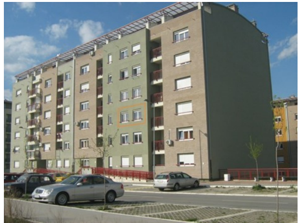
Слика 1. Спољашњи изглед фасаде зграде, позиција стана у коме су вршена мерења је означена црвеним правоугаоником.
