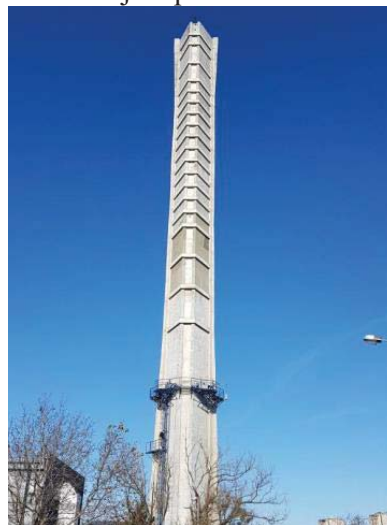
Slika 11 - Izgled dimnjaka posle sanacije
