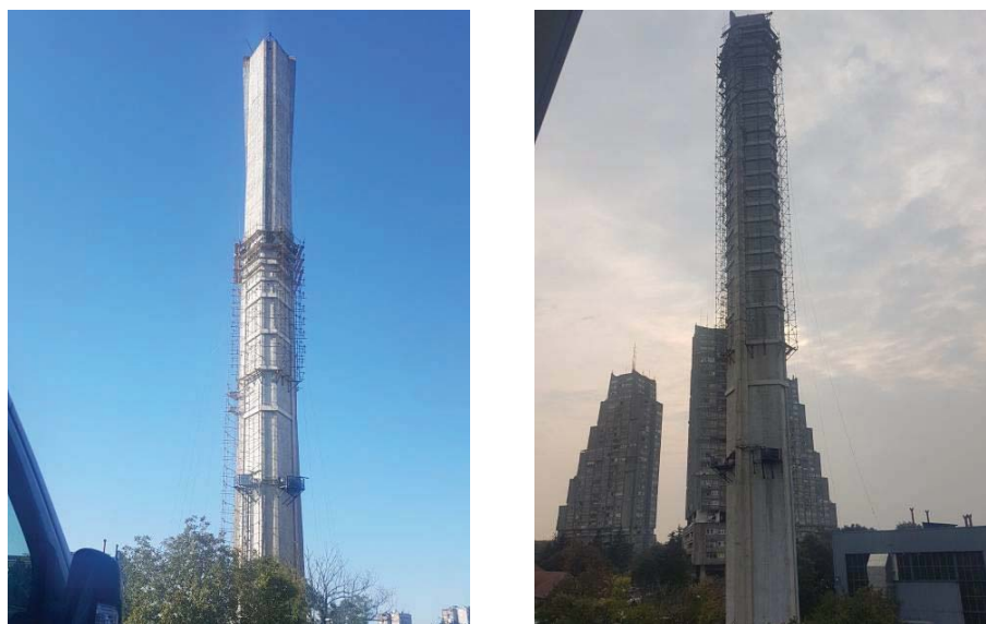
Slika 8 - Skela za izvođenja sanacije na donjem (levo) gornjem delu dimnjaka (desno)
