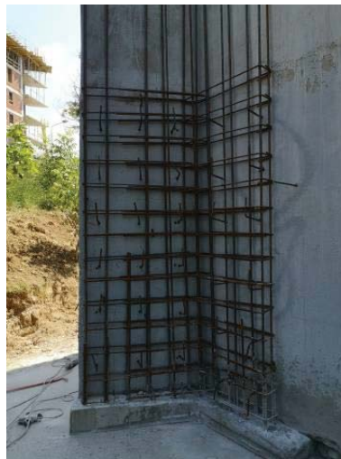
Slika 6 - Detalj oplata i armature za ojačanje dimnjaka na vezi sa temeljem
