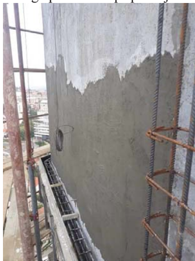
Slika 10 - Sanacije spoljne površine dimnjaka i izrada horizontalnih i vertikalnih AB srklaža
