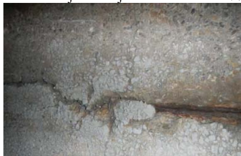
Slika 4 - Horizontalna (levo) i vertikalna (desno) pukotina na AB zidu dimnjaka sa unutrašnje strane
