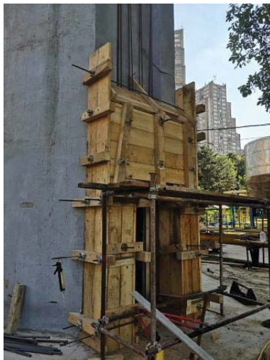
Slika 6 - Detalj oplata i armature za ojačanje dimnjaka na vezi sa temeljem
