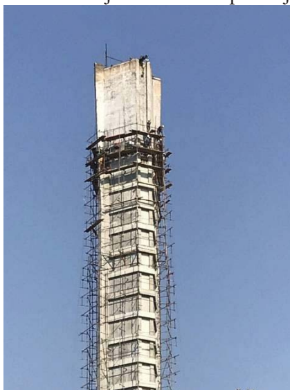
Slika 7 - Faza izvođenja sanacije na gornjem delu dimnjaka
