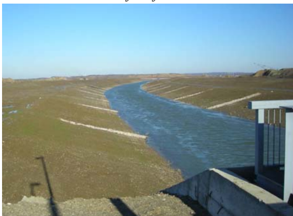
Slika 1 - Novo korito Kolubare – pogled sa tehnološkog mosta nizvodno
