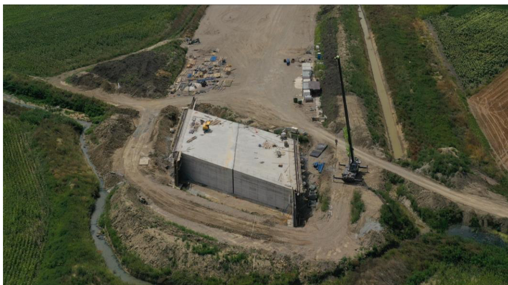
Slika.7 Izgled izvedenog mosta M3 preko kanala Vrtić
