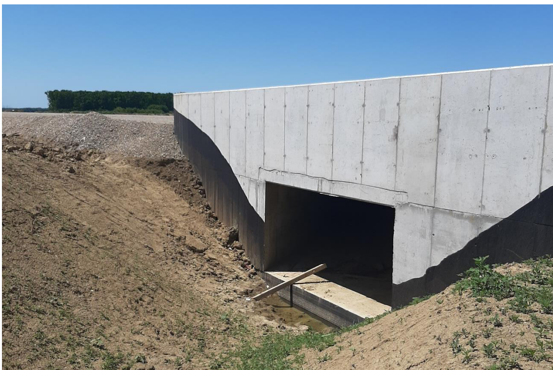
Slika. 2 Izveden pločasti propust – ulaz
