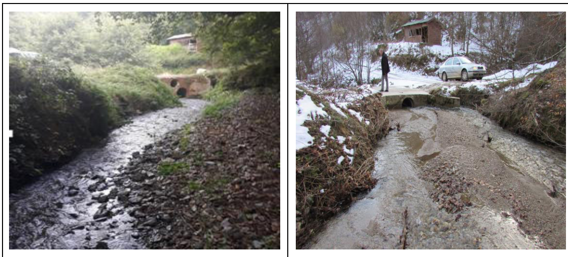
Slika 7: Ušće potoka Klade-poslije bujice akumulirani nanos
