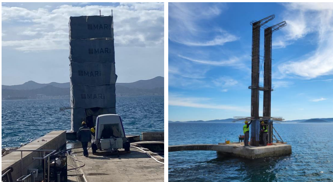
Slika 6. Hidrodemoliranje stupišta obloženog zaštitnom tkaninom (lijevo) i izgled konstrukcije skakaone nakon završetka rušenja ploča podesta i hidrodemoliranja stupova (desno)
