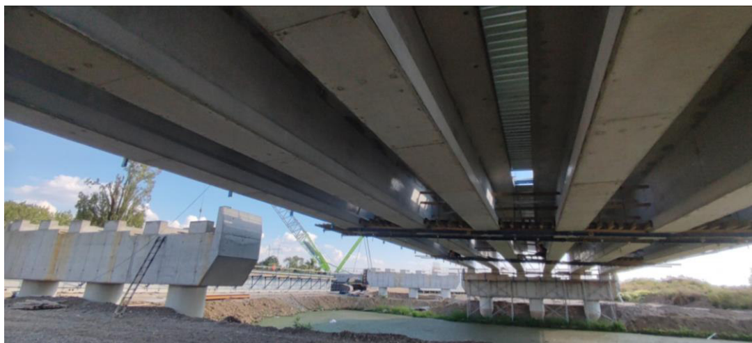
Slika. 13 Izgled mosta preko reke Bosut
