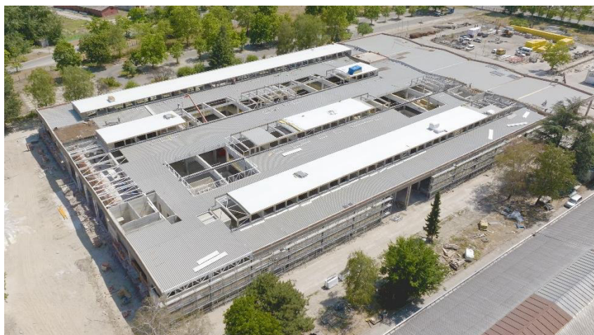
Slika 10. Montaža krovnog pokrivača i fasade
