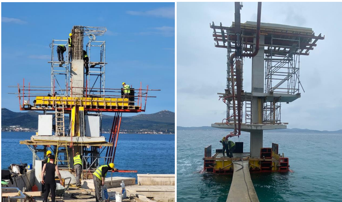
Slika 8. Armiranje ploče podesta na visini od cca 5 m iznad mora (lijevo) i betoniranje temelja skakaone u moru (desno)
