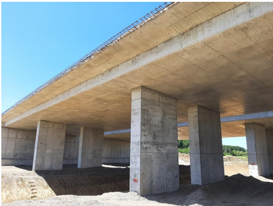
Slika. 9 Izgled izvedenog mosta preko Glavnog kanala
