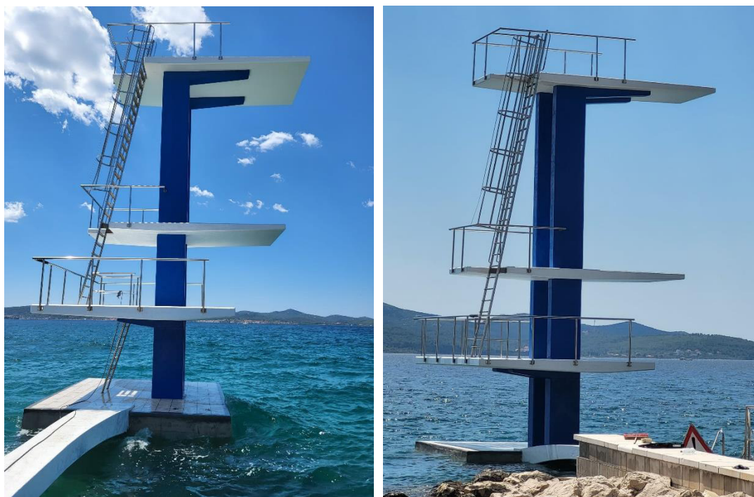
Slika 10. Pogled na skakaonu i pristupni most nakon završetka svih sanacijskih radova
