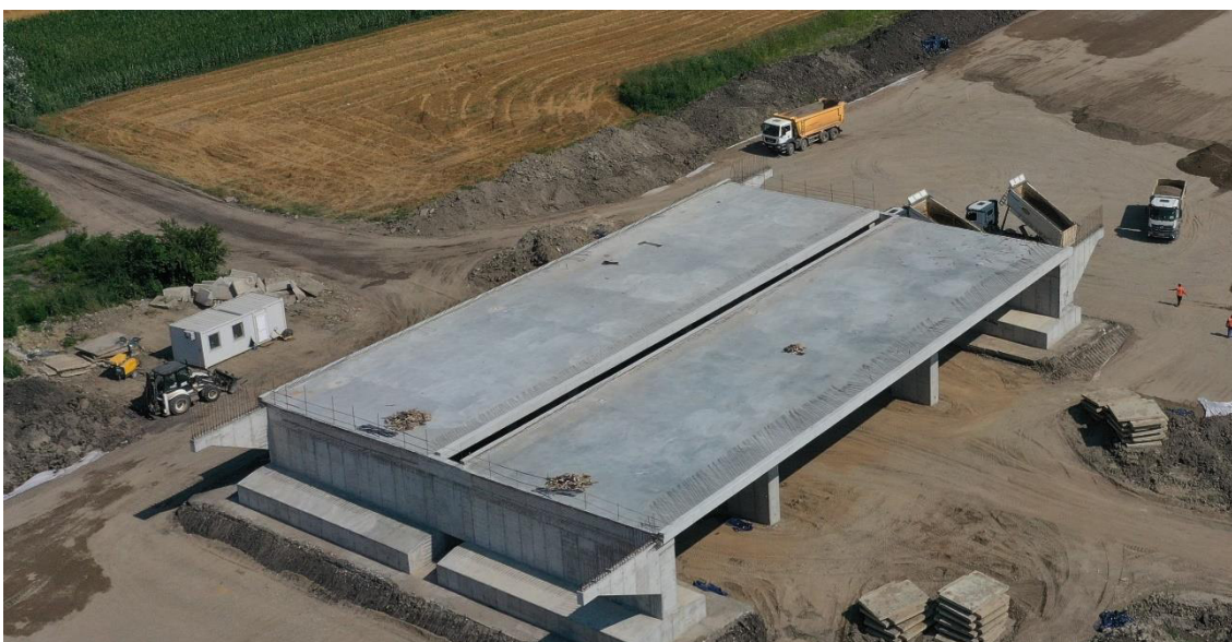
Slika. 10 Izgled izvedenog mosta preko puta za ciglanu
