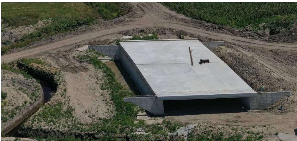
Slika. 6 Izgled izvedenog mosta svetlog otvora 14m
