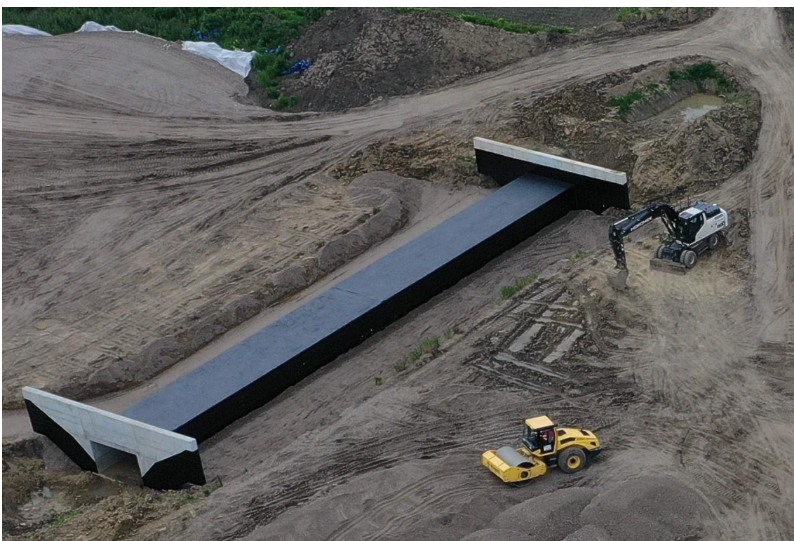
Slika. 3 Izveden pločasti propust
