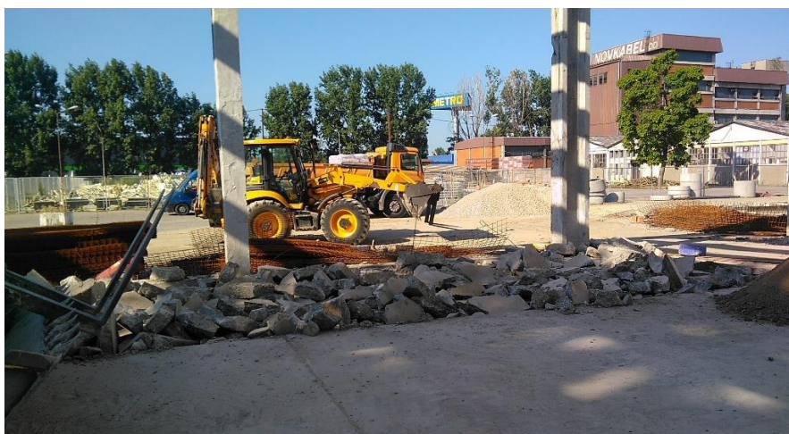
Slika 9. Rušenje podne ploče (Data centar)
