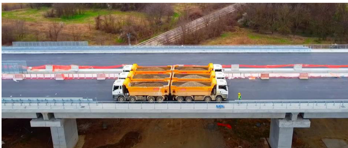
Slika 1. Probno opterećenja mostova na Moravskom Koridoru [4]
