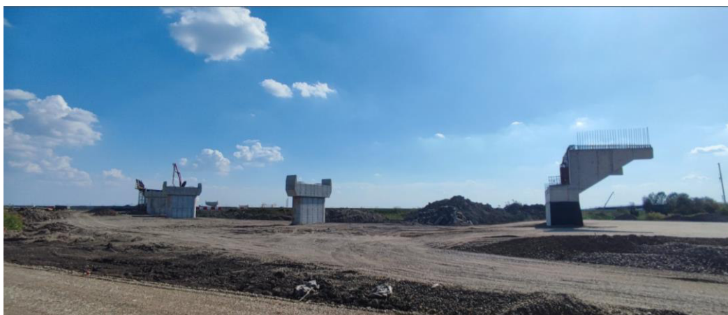
Slika. 16 Izvođenje petlje Kuzmin stubovi nadvožnjaka
