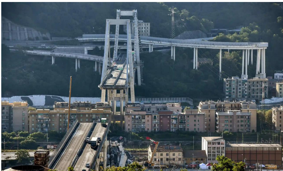
Slika 3. Srušeni Morandi most u Italiji, 60 godina nakon izgradnje
