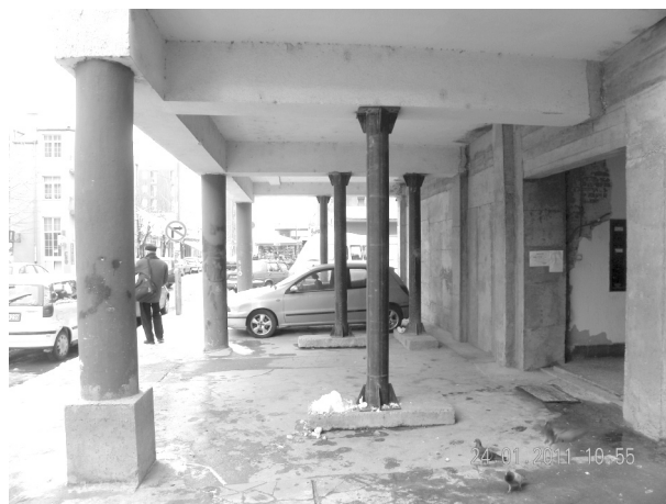
Slika 6. Ojačanje jako oštećenog, u odnosu na kalkansku površinu “uvučenog” zida od opeke, novim armiranobetonskim zidom – interventno sanaciono rešenje
