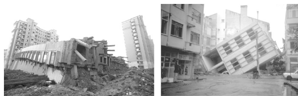
Slika 20. Oštećenja objekata usled likvefakcije u toku zemljotresa
