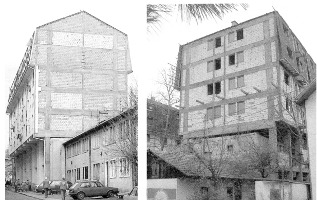
Slika 12. Drastični primeri pogrešnih nadogradnji zgrada
