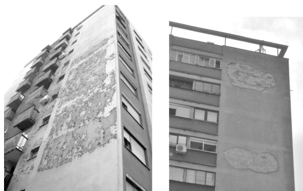
Slika 24. Pojava ljuskanja i otpadanja završnih slojeva zida usled dejstva vlage
