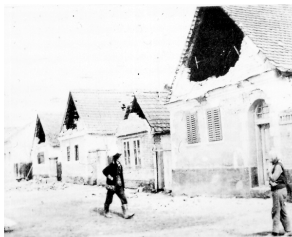
Slika 16. Nepravilno izveden zabitni (kalkanski) zid ruši se pri slabijem zamljotresu
