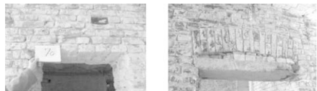
Slika 12. Otvori u zidovima izvedeni bez odgovarajućih nadvratnika i nadprozornika
