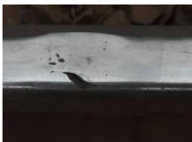
Slika 10. Head checking defekt sa odvajanjem čelika na zaobljenoj ivici glave šine Figure 10. Head checking with the scaling (spalling)
