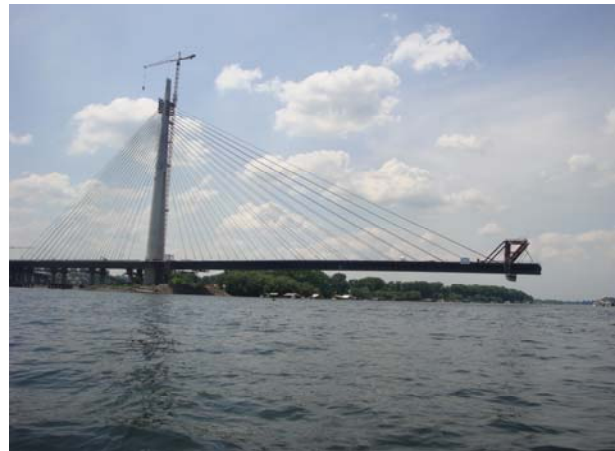
Slika 1. Most na Adi u toku izgradnje (maj 2011).
