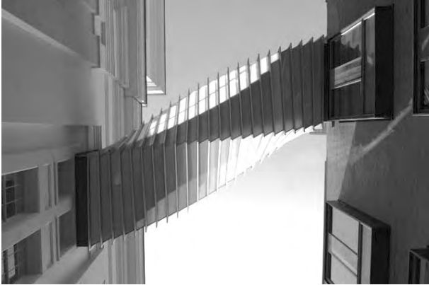
Slika 3. Dva sistema kružnih preseka jednogranog eliptičkog hiperboloida
