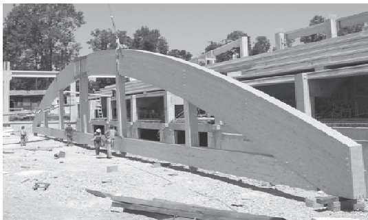
Slika 2.- Glavni nosač pre podizanja u projektovani položaj
