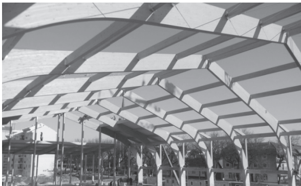
Slika 6.- Krovna konstrukcija zatvorenih bazena u Subotici
