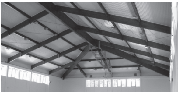
Slika 8.- Krovna konstrukcija sportske hale u Kragujevcu
