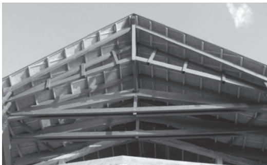
Slika 15.- Krovna konstrukcija Restorana Sidro na Srebrnom jezeru
