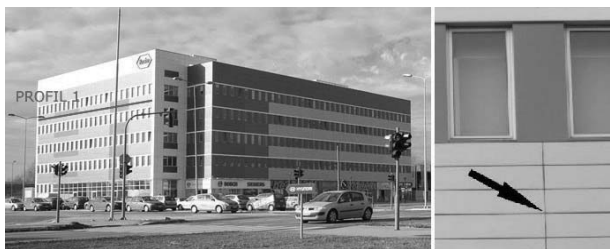
Slika 14. - Izgled objekta GTC Square (levo) i detalj strukturalne fasade (desno)
