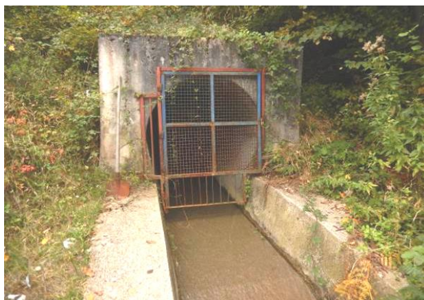
Слика 3. а) Шахтни прелив б) Спој колектора и канала
