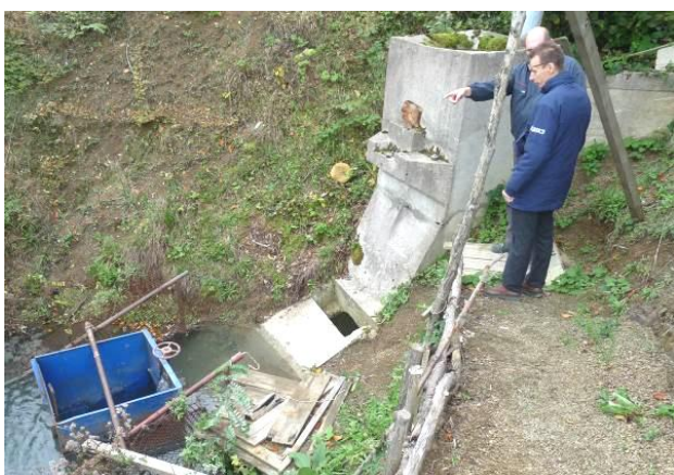
Слика 3. а) Шахтни прелив б) Спој колектора и канала
