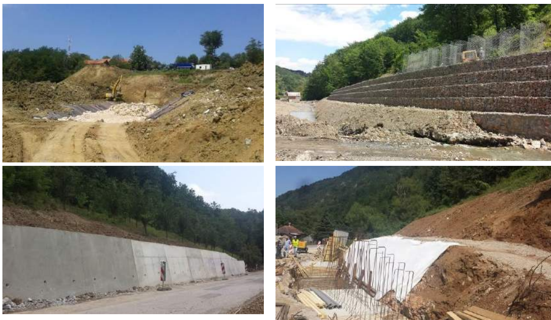
Slika 1. Klizište u Vinjištu-početak radova; Gabionska konstrukcija u zaseoku Troska Potporni zid klizišta na putu Drakčiči-Pekčanica; Sanacija klizišta na putu Valjevo-Kosjerić
