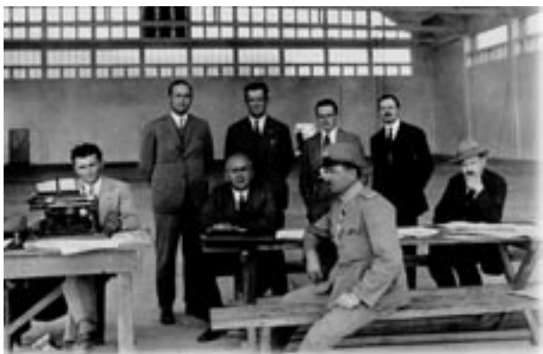
Na gradilištu hangara koji je projektovao Milanković
