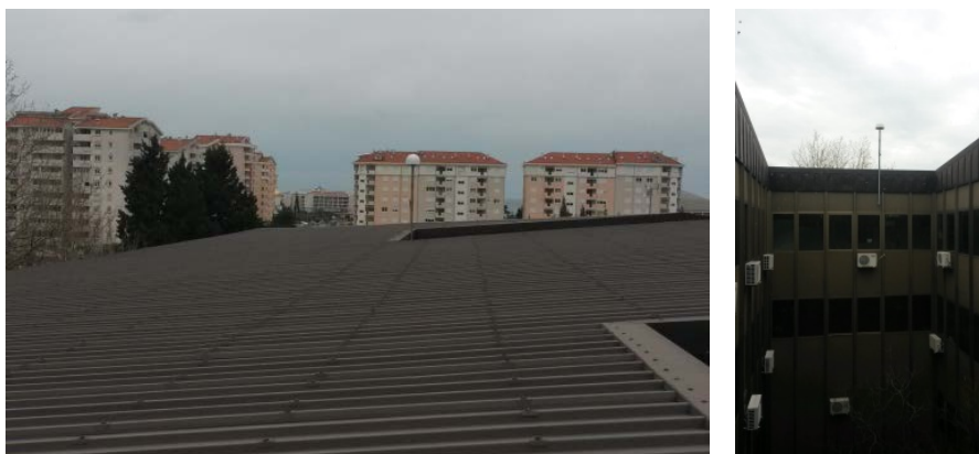
Slika 7.1.9 – Antena LEIAT504 na krovu zgrade Gradske skupštine u Baru
