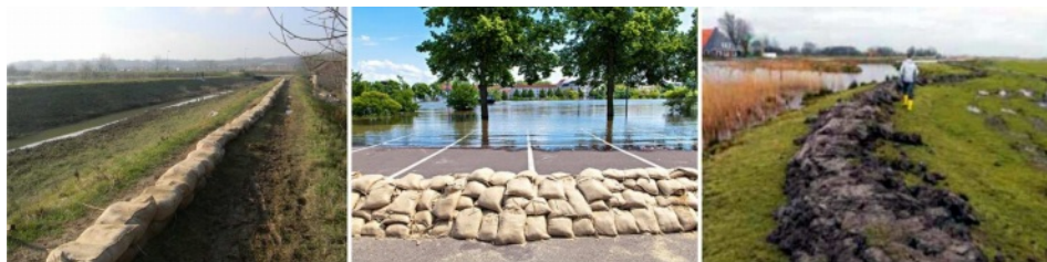
Slika 6.26: Konvencionalno nadvišenje nasipa; sleva na desno: pravilno i proizvoljno naslagane vreće od jute punjene peskom [305] i dodatni od glinovitog materijala [33].
