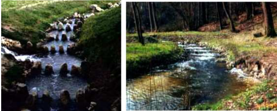
Slika 5.26: Primeri zaobilaznih kanala na rekama Varel Beke (Varrel Bäke) i Šteber (Stöbber) u Nemačkoj [34].
