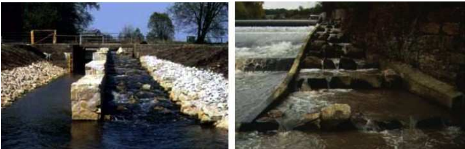
Slika 5.22: Riblje rampe na rekama Doln (Dölln) i Fils (Fils) u Nemačkoj [34].
