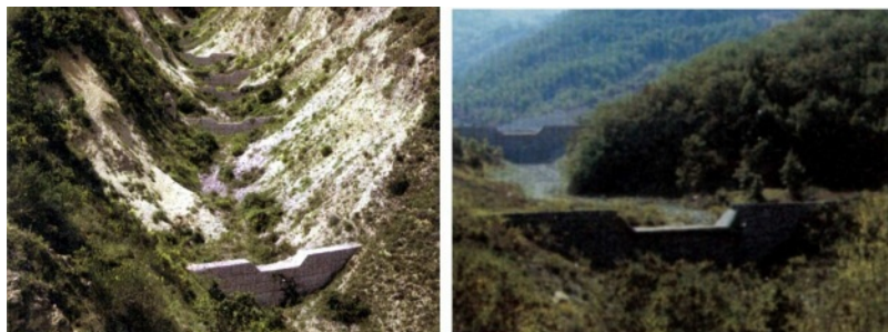
Slika 3.92: Primeri bujičnih pregrada od gabiona [1].
