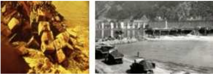
Slika 4.39: Pregrađivanje Dunava u toku izgradnje HEPS Đerdap I; radovi su sa srpske strane obavljani ubacivanjem betonskih kocki, a sa rumunske strane, nasipanjem kamena sa privremenog mosta [51].
