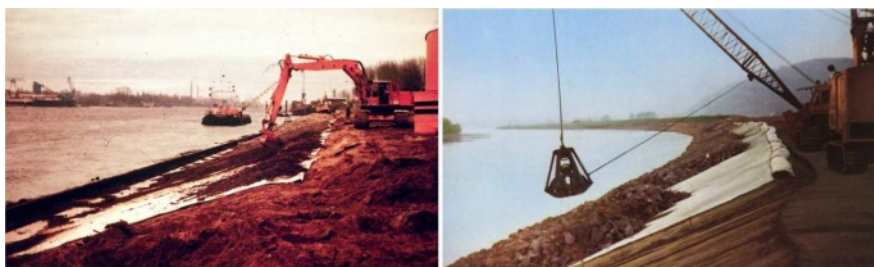
Slika 4.3: Izgradnja obaloutvrde od kamenog nabačaja na podlozi od geotekstila na velikom aluvijalnom vodotoku [141].
