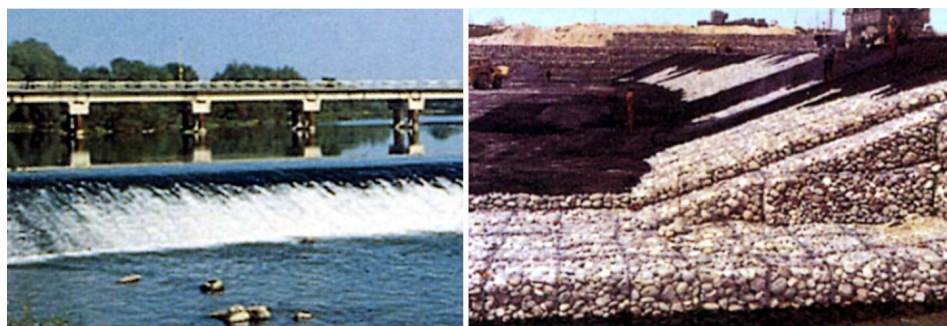
Slika 3.89: Prelivanje pregrade od gabiona na reci Brenta u Italiji (regija Veneto, južno od Venecije) [1, 137].
