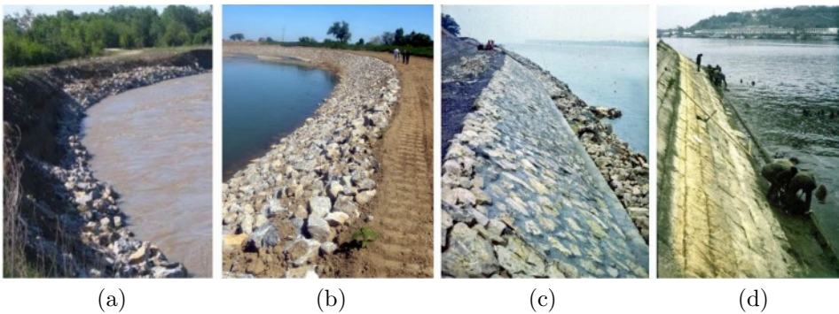
Slika 3.33: Primeri obaloutvrda od kamena: (a) kameni nabačaj na Velikoj Moravi; (b) kameni nabačaj na Jadru; (c) kamen zaliven cementnim malterom na Dunavu kod Grocke; (d) tesani kameni blokovi na Savi kod Beograda.
