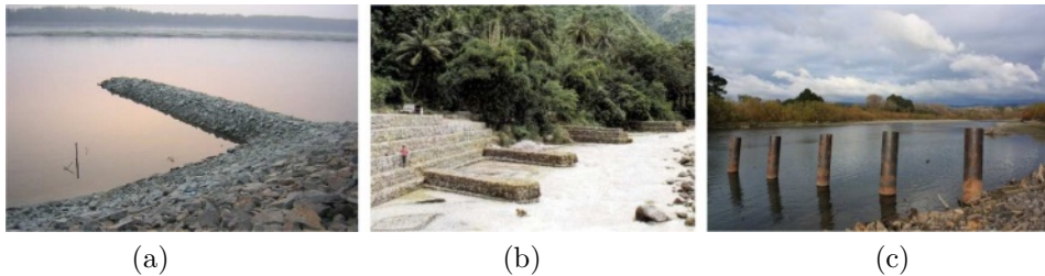
Slika 3.62: Naperi od: (a) kamena; (b) gabiona [137]; (c) cevastih šipova [268].
