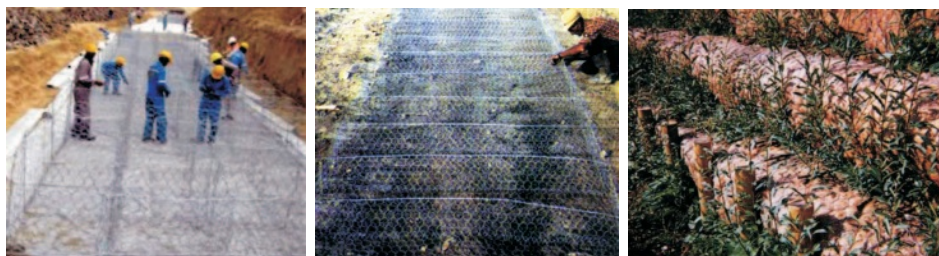
Slika 3.11: Ugradnja i ozelenjavanje kutijastih gabiona [137].
