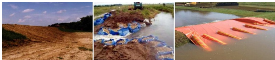
Slika 6.32: Sleva na desno: zatvaranje breše glinovitim materijalom; zaustavljanje širenja breše „džambo” vrećama sa kamenom ispunom [33]; fiksiranje breše folijom i cevastim balastom od poliesterskog materijala presvučenog plastikom [17].
