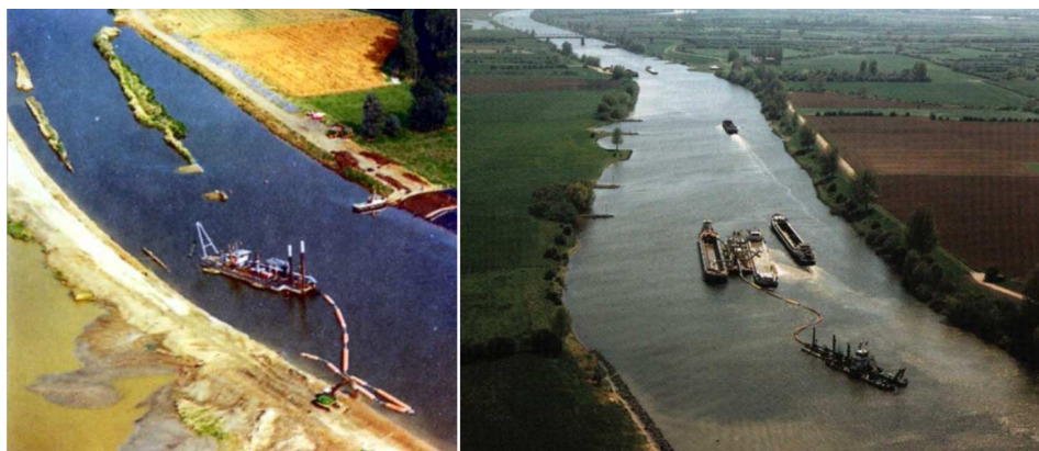
Slika 4.70: Transport i odlaganje izbagerovanog materijala; levo: nasipanje depozita na obali; desno: hidraulički transport materijala do plovila za odvoženje izbagerovanog materijala.
