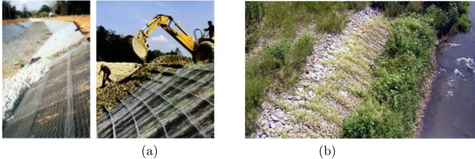
Slika 3.37: Gabionski madraci; a – ugradnja [2]; b – obaloutvrda na reci Jadar.
