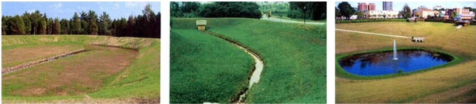
Slika 6.46: Primeri povremenih i stalnih gradskih retenzionih bazena.
