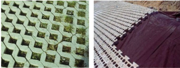
Slika 3.47: Tipovi slobodnih betonskih blokova
