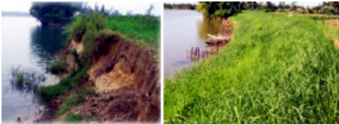
Slika 3.3: Zatravljanje obale kao zaštita od fluvialne erozije.
