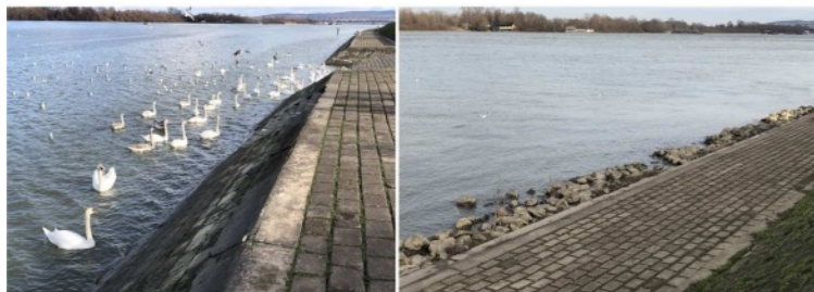
Iz arhive: obaloutvrde u Beogradu; gore: obala ispod pilona Mosta na Adi; dole: šetališna bankina obaloutvrde na Dunavu, sa vidljivom nožicom pri niskom vodostaju.
