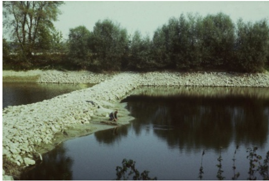
Slika 3.85: Pregrada na rukavcu Dunava kod Mohova (km 1311÷1308); izgrađena je od slaganog kamena, bez glinenog jezgra, tako da je telo pregrade vodopropusno.
