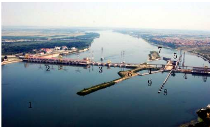
Slika 7.9: Hidrosistem „Đerdap II”: 1 – akumulacija; 2 – srpska elektrana; 3 – prelivna brana; 4 – neprelivna nasuta brana; 5 – srpska prevodnica; 6, 7 – neuklonjeni ostaci zagata; 8 – usmeravajuća građevina; 9 – prilazni kanal [188].
