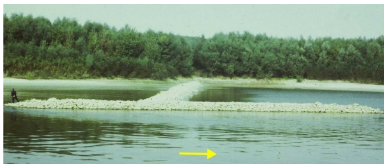
Slika 3.68: Naper sa krilima na Dunavu, sektor „Neštin-Susek” (km 1290); tipična dužina uzvodnog krila iznosi 10 \div 30 m, a nizvodnog, 20 \div 100 m.
