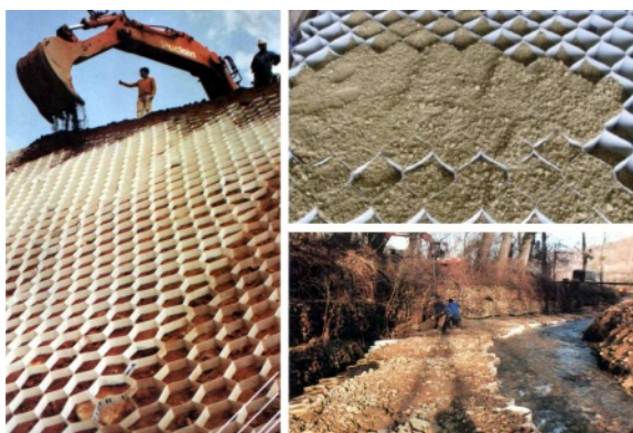
Slika 3.50: Primena geosaća tipa „ArmaTer © ” [136].
