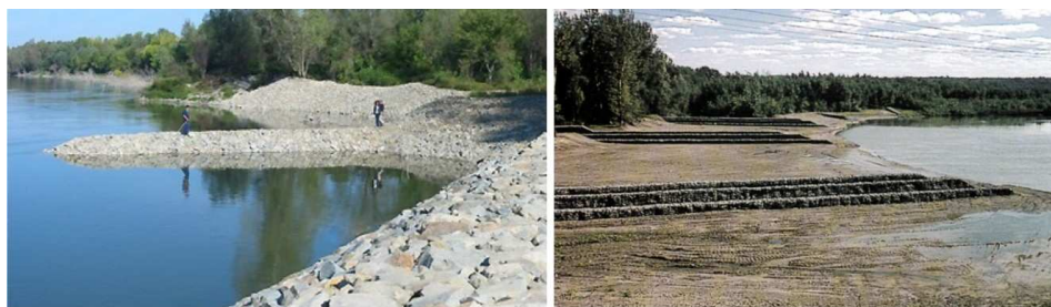
Slika 2.35: Naperi: prost naper od kamena (levo) i naperi od gabiona (desno) [137].
