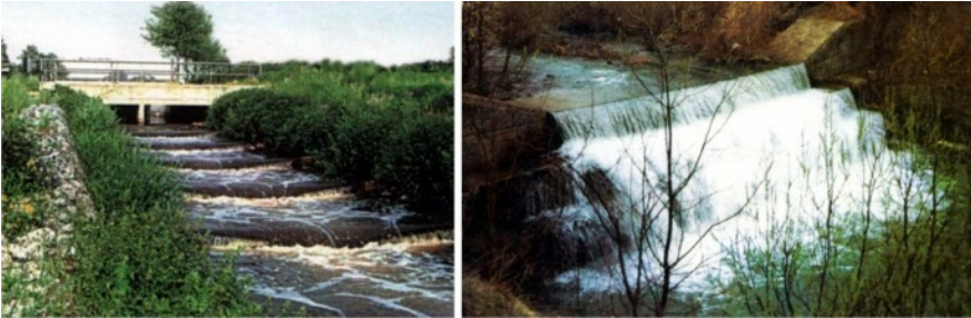
Slika 3.97: Stepenaste kaskade od gabiona [1, 137].
