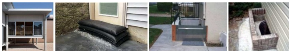
Slika 6.50: Primeri lokalne zaštite od poplava; sleva na desno: izdizanje objekta [313], elastične i metalne barijere [249, 314], zaštita podrumskih prostorija [249].
