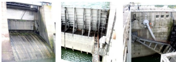
Slika 6.35: Tablasta ustava (HE Đerdap I) i segmentna ustava (HE Đerdap II).
