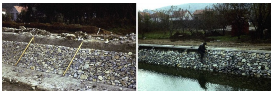
Slika 4.4: Izgradnja obaloutvrde od sлагanog kamena na malom vodotoku (reka Bolečica, desna pritoka Dunava, u Leštanima kraj Beograda).
