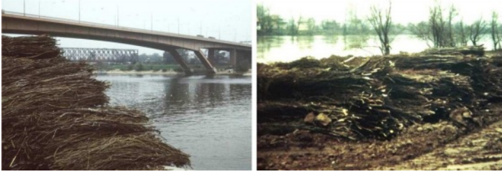
Slika 3.4: Vrbovo pruće pripravljeno za izradu fašinskih madraca u sklopu uređenja obale u Beogradu i regulacionih radova na Velikoj Moravi kod Bagrdana.
