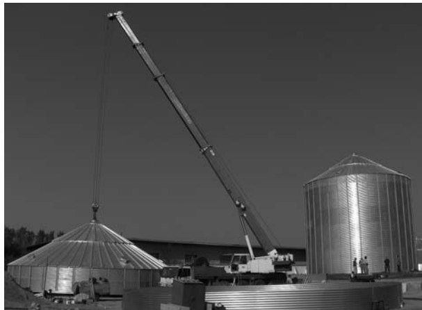
Slika 6. Podizanje kranom od 120t
