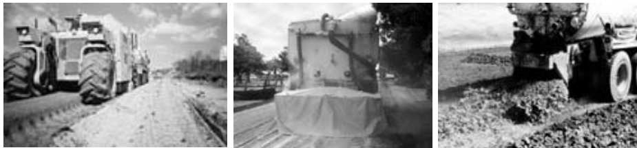
Slika 1. Metoda izrade stabilizacije miješanjem na licu mjesta
