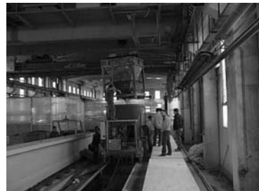
Slika 2. Dopremanje betona kiblom po kranskoj stazi
