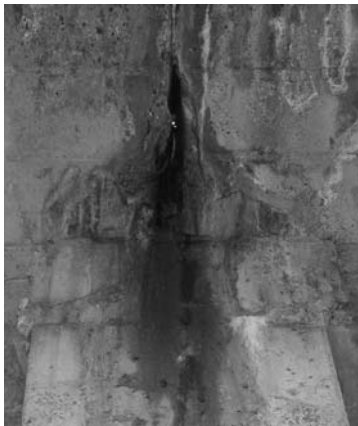
Slika 7. Donja strana AB ploče prilazne konstrukcije
