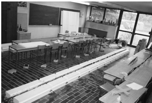
Slika 2. Polumontažna StiroFert gredica dužine 8m, pripremljena za montažu na zidove
