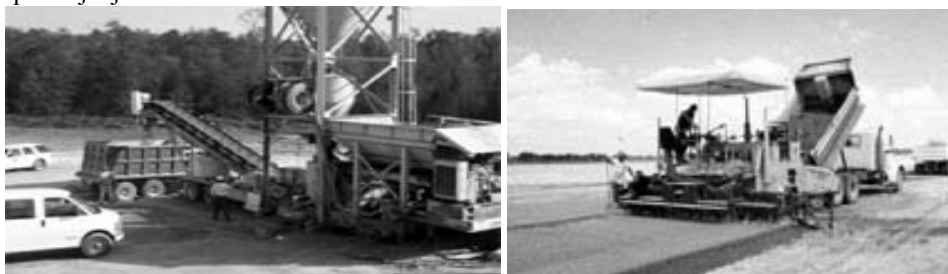
Slika 2. Metoda izrade stabilizacije miješanjem u proizvodnom postrojenju
