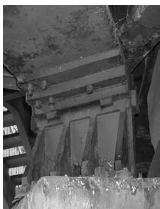
Slika 4. Desno nepokretno ležište
