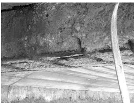
Slika 8. Stanje AB grede pešačkih staza
