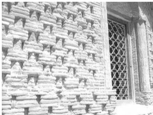
Sl. 2 Slog opeka na fasadi, stub i vrata – graditeljski znakovi; Buhara
