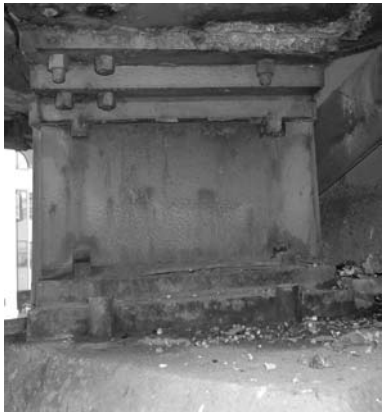
Slika 5. Desno pokretno ležište na strani Mladenovca
