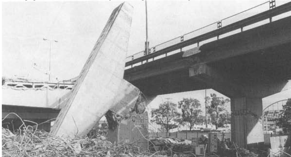
Slika 5 – Fleksiono-smičući lom stuba usled preranog završetka podužne armature, 1995. zemljotres u Kobe-u, Japan [3]
