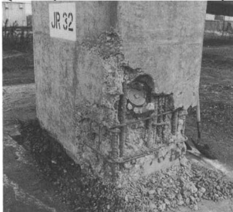
Slika 6 – a) Lom stuba na mestu preklopa podužne armature, 1995. zemljotres u Kobe-u, Japan, i b) Dijagram interakcije stuba [3]
