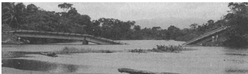
Slika 3 – Kolaps usled likvefakcije, godine 1990. zemljotres u Kostariki [3]
