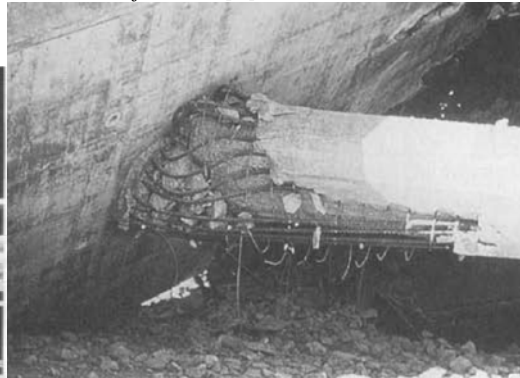
Slika 7 – a) Otkaz smicanjem bez formiranja plastičnog zgloba na krajevima stuba, i b) lom uled nedovoljnog utezanja plastičnog zgloba, 1971. zemljotres u San Fernando, SAD [3]
