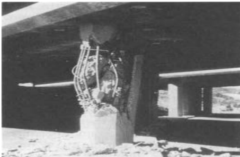
Slika 7 – a) Otkaz smicanjem bez formiranja plastičnog zgloba na krajevima stuba, i b) lom uled nedovoljnog utezanja plastičnog zgloba, 1971. zemljotres u San Fernando, SAD [3]
