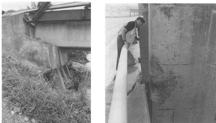
Slika 4 – a) Obrtanje obalnog stuba, godine 1990. zemljotres u Kostariki b) Sudaranje susednih mostovskih konstrukcija, godina 1989 Loma Prieta, Kalifornija, SAD [3]
