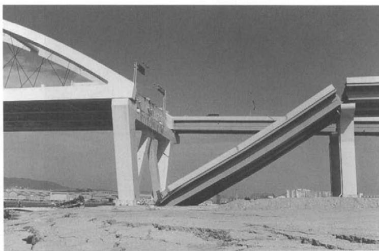
Slika 1 – Dislociranje rasponske konstrukcije iz ležišta, godina 1995. posle zemljotresa u Kobe-u [3]
