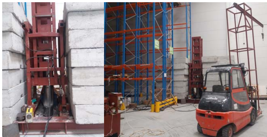
Slika 2 – Izvođenje utisnutih šipova
